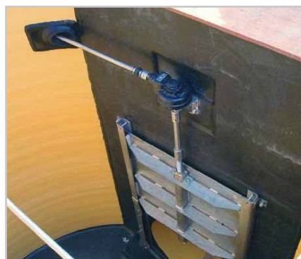
Tesaco Schieber der C20 Serie Umlenkgetriebe
