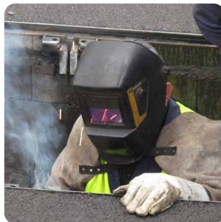
Sonderbau Mitarbeiter bei einer Deckelsanierung vor Ort
