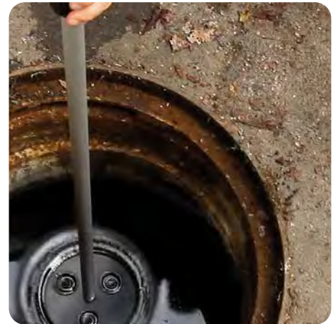
Sichtkontrolle der Abscheideroberfläche bei einem SeparatorBLUE
