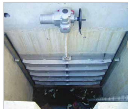
Tesaco Schieber der C20 Serie mit E-Antrieb
