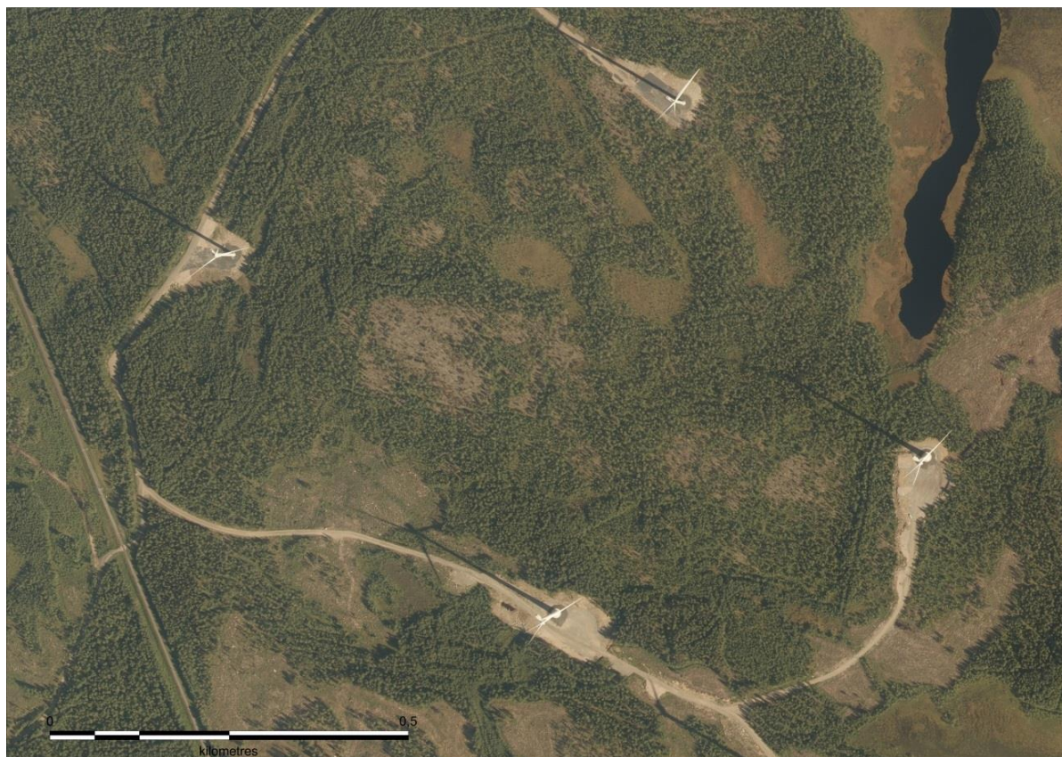
Kuva 64. Ilmakuvassa näkyy toiminnassa olevia tuulivoimaloita. Tuulivoimaloita varten on rakennettu huoltotiet ja nostokentät. Tuulivoimaloiden ympäristössä ja välialueilla aikaisempi maankäyttö on säilynyt ennallaan.
