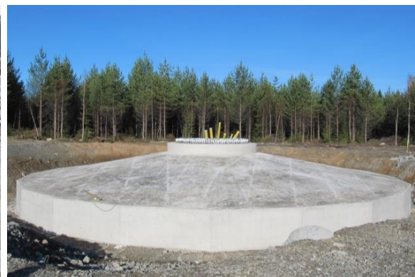
Kuva 75. Tuulivoimalan perustusten rakentamista. (Kuvat: Leila Väyrynen, FCG)
