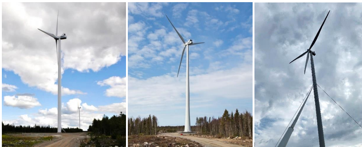
Kuva 65. Vasemmalla on esimerkki teräslieriötornista, keskellä hybriditornista ja oikealla harustetusta tornista. 250 metrin korkeuden ylittäminen ei välttämättä tarkoita harustettua tornia. (Kuvat: Leila Väyrynen ja Ville Suorsa, FCG sekä Jarkko Finnilä, Carelin.
