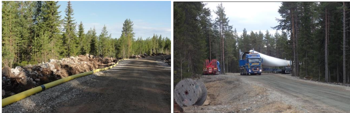
Kuva 70. (Vasemmalla) Esimerkki tuulivoimapuiston rakennus- ja huoltotiestä. Teitä käytetään muun muassa betonin, soran ja voimaloiden komponenttien kuljetuksiin sekä tuulivoimapuiston käyttöväheessä huoltoajoihin. Maakaapeli sijoitetaan ojakaivantoon tien reuna-alueelle. (Oikealla) Tuulivoimalan osia kuljetetaan erikoiskuljetuksina. (Kuvat: Ville Suorsa / FCG).
