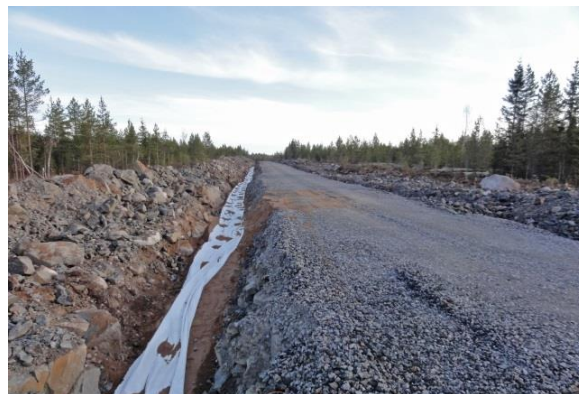
Kuva 74. Maakaapelit upotetaan huoltoteiden yhteyteen (kuvat: Ville Suorsa/FCG).
