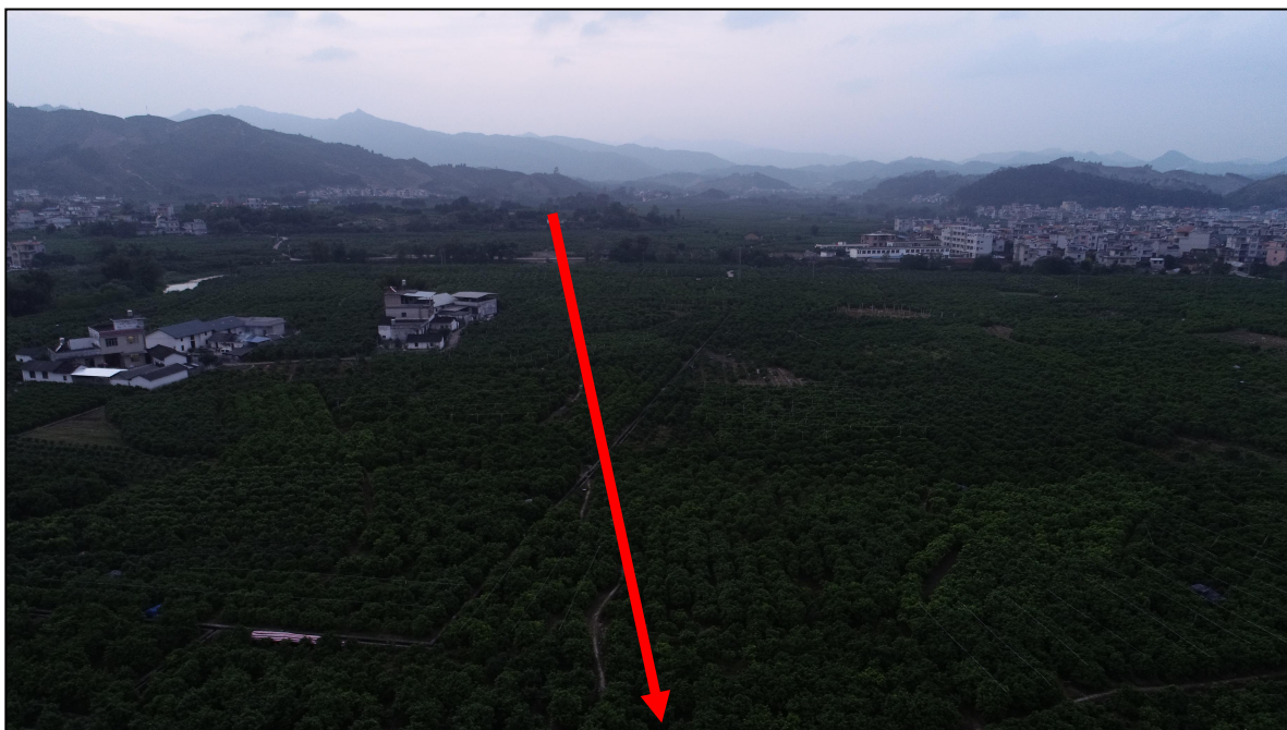
K8+500-K10+000 段道路沿线现状照片
