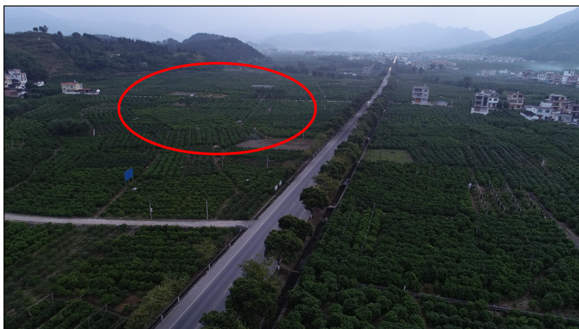
修仁互通现状照片图
