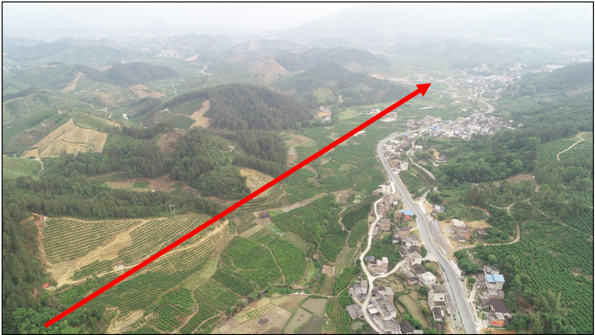
K2+000-K4+000 段道路沿线现状照片
