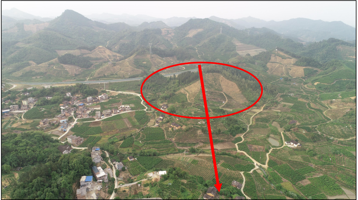
项目起点（茶城互通）现状照片
