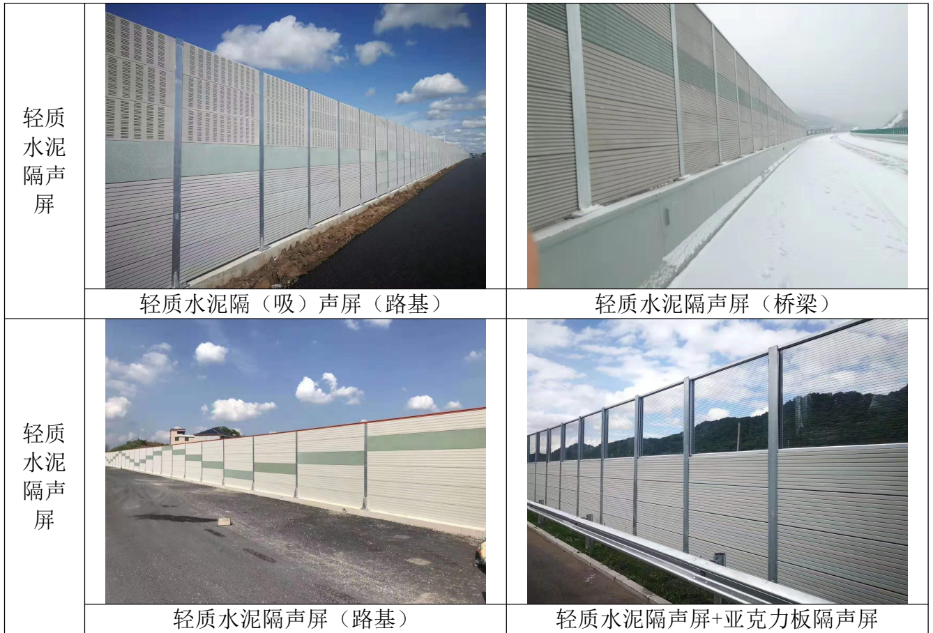
图 5.3-1 不同材料声屏障实景图
