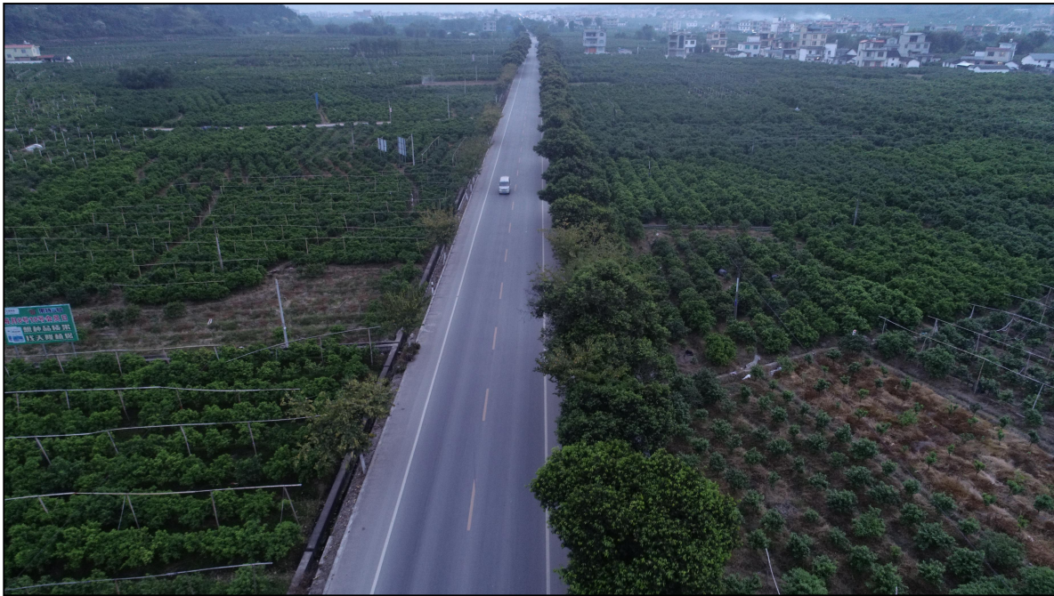
修仁互通连接国道 G323 处现状照片
