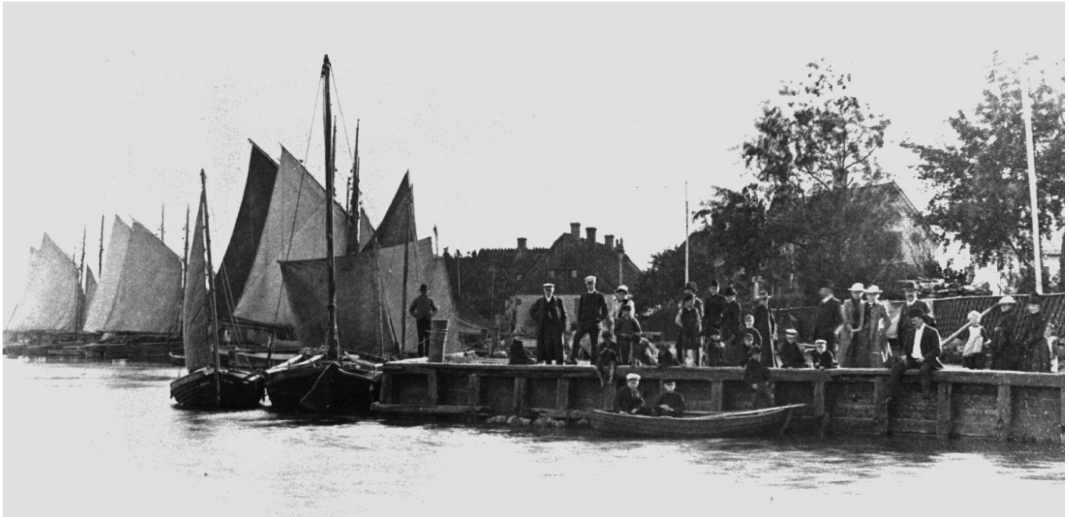
Fiskekvassar med seglen på tork vid "Råttefällan" i Råå hamn (vid nuvarande Varvsgatan och
