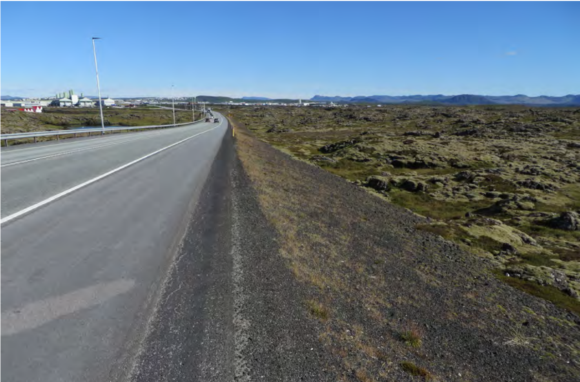
20. mynd. Vegfláar við núverandi Reykjanesbraut eru í vegstæði nýrrar tvöfaldrar akbrautar til austurs, sem og aðliggjandi vistgerðir eins og lynghraunavist í hrauninu frá Hrítagjárdyngju sem hér sést. Ljós. Rannveig Thoroddsen, 5. september 2020.
