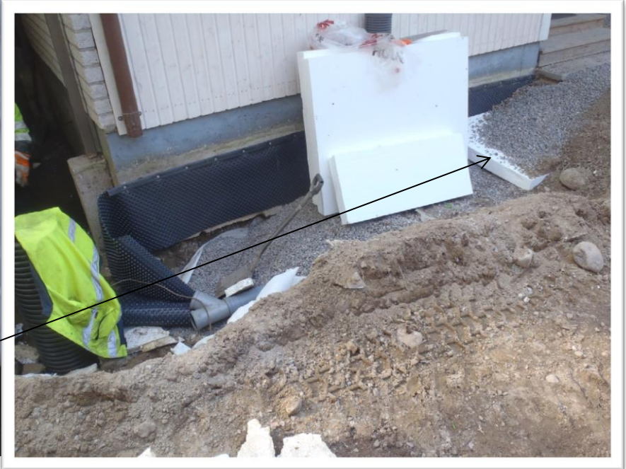
Routaeristyslevy asennetaan vaakaan ja putket jäävät levyjen alle. Näin estetään putkien jäätyminen. Eristelevy asennetaan siten että se kallistaa pois päin rakennuksesta.
