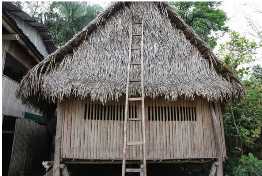
Figura 3-2. Vivienda cocama a orillas del río Samiria, con techo construido con las hojas de Euterpe precatoria y paredes con tablas del tronco de la misma especie, Departamento de Loreto, Perú. (N. Paniagua-Zambrana)
