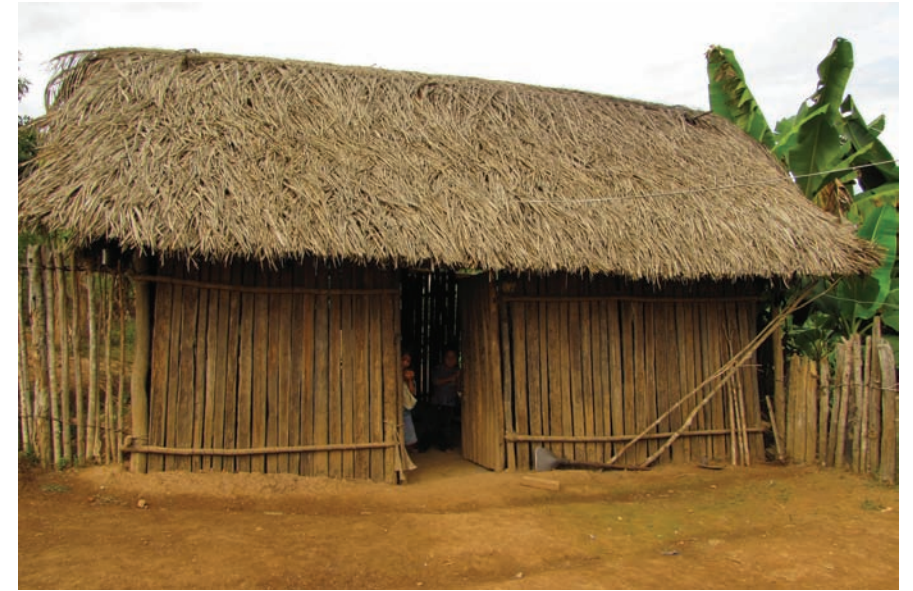
Figura 3-3. Vivienda cocama a orillas del río Samiria con techo construido con las hojas de Euterpe precatoria y paredes con tablas del tronco de la misma especie, Departamento de Loreto, Perú. (N. Paniagua-Zambrana)
