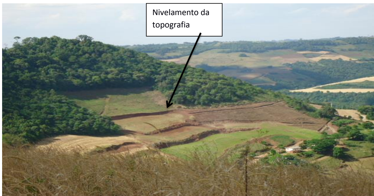
Figura 12- Construção de nivelamento da topografia do relevo.
