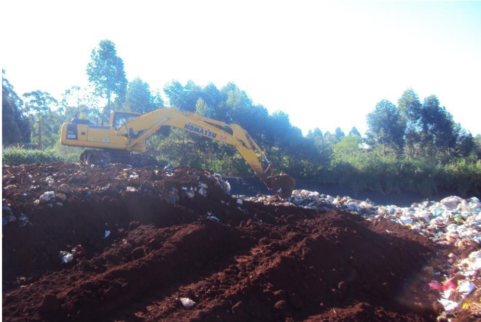
Figura 12. Rejeitos e resíduos orgânicos encaminhados para a célula de recebimento
