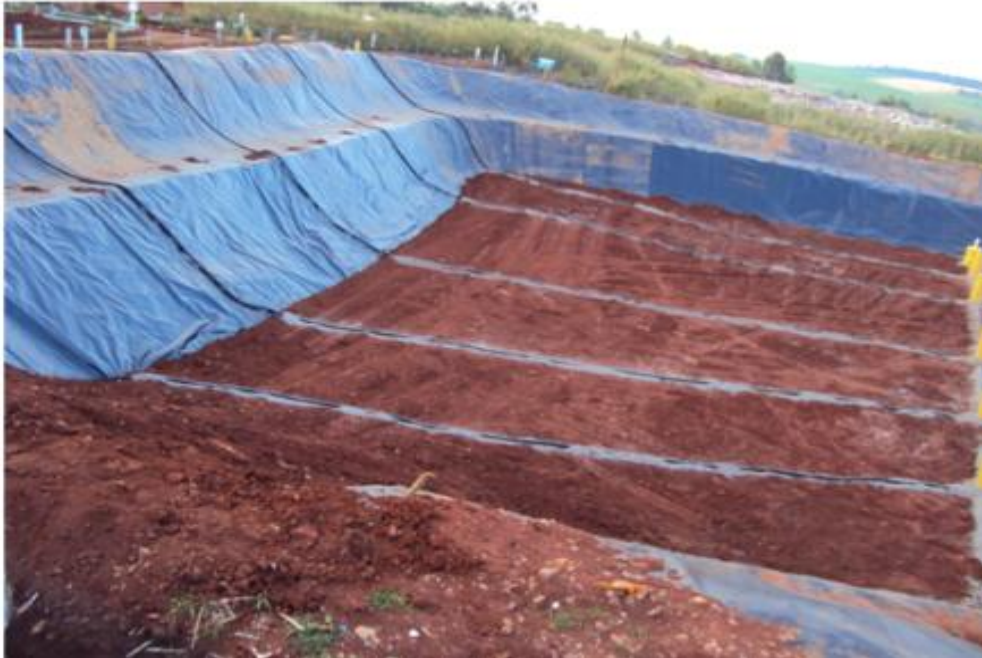
Figura 5. Célula de recebimento de resíduos sólidos urbanos
