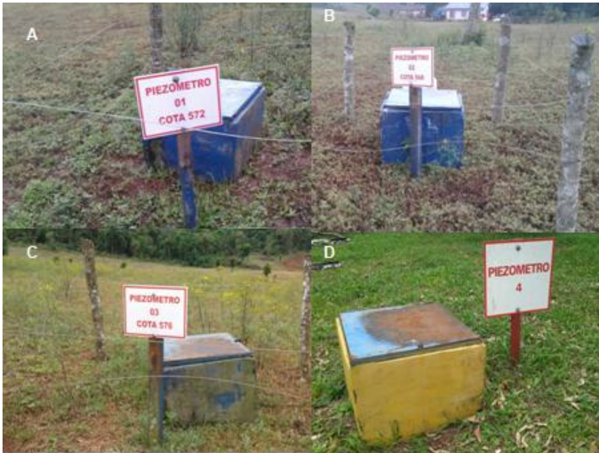
Figura 29. Imagem dos poços de monitoramento PJ1, PJ2, PJ3 e PM4
