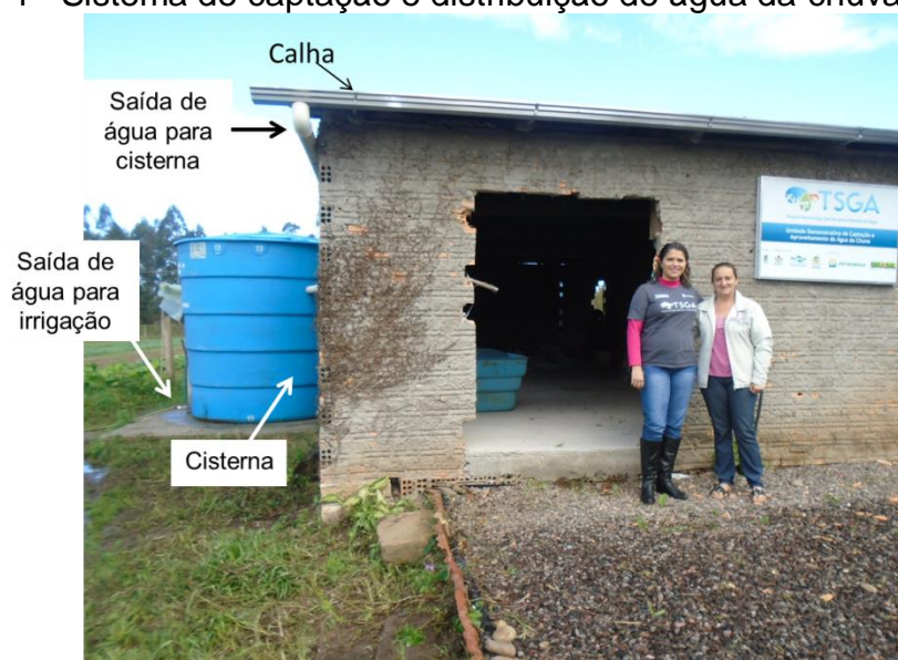
Figura 4 - Sistema de captação e distribuição de água da chuva da U2.
