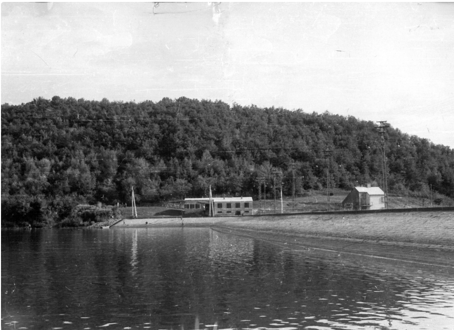
11. ábra: A Rakacai tározó végében épült gátórházak és a gát. Fig. 11. The dike and dike-reeve houses at the edge of the Rakaca reservoir.
