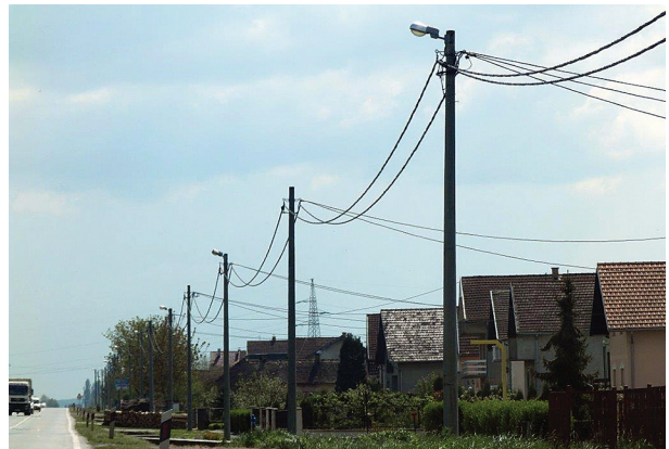
1. ábra Kifesztültségű szabadvezeték-hálózat (kettős rendszer szigetelt vezetékkel)
