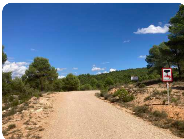
Imatge 184. - Una forest, per a ser gestionada activament, requereix pistes forestals en bon estat, a més de la seua senyalització. Font: Medi XXI GSA.
