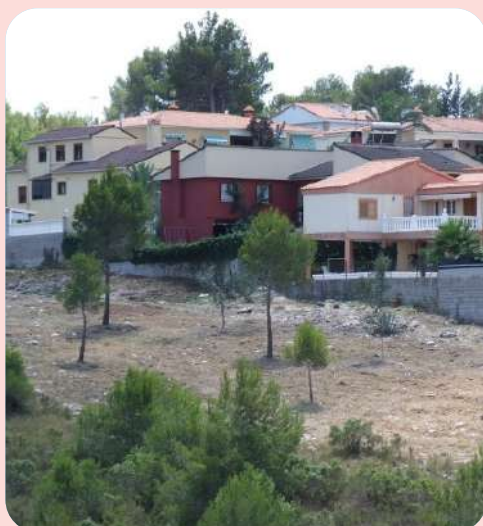
Imatge 39. - Franja perimetral de seguretat en una urbanització en Interfície Urbanoforestal. Font: Medi XXI GSA.
