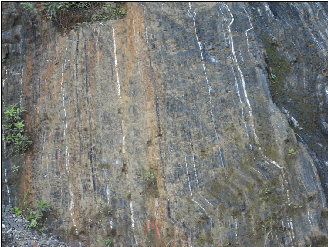
Figura 124. Fallas menores de acomodación, con desplazamientos reducidos.
