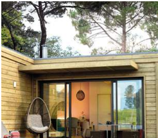
CENTER PARC BOIS AUX DAIMS, Morton SAS DLE BNP Paribas REIM France Certification HQE Bâtiment Tertiaire Exceptionnel
