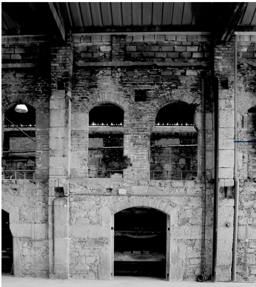
Fig. 56 | Parede estrutural da Fábrica Jerónimo Pereira Campos, Alvarães - Viana do Castelo
