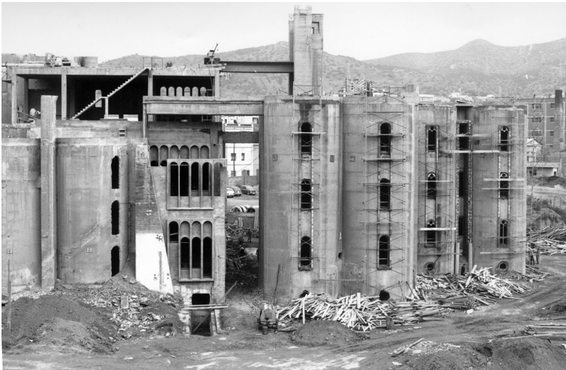
Fig. 35 | Fábrica de cimento em processo de intervenção.
