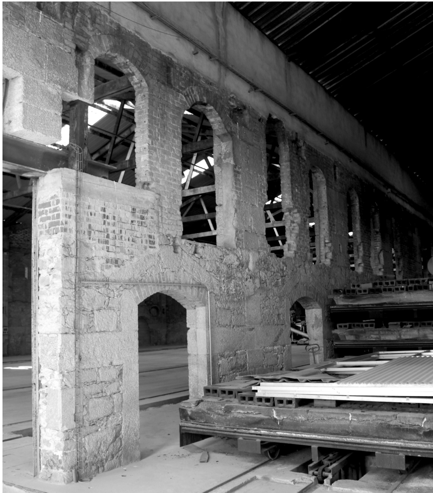
Fig. 55 | Parede estrutural da Fábrica Jerónimo Pereira Campos, Alvarães - Viana do Castelo
