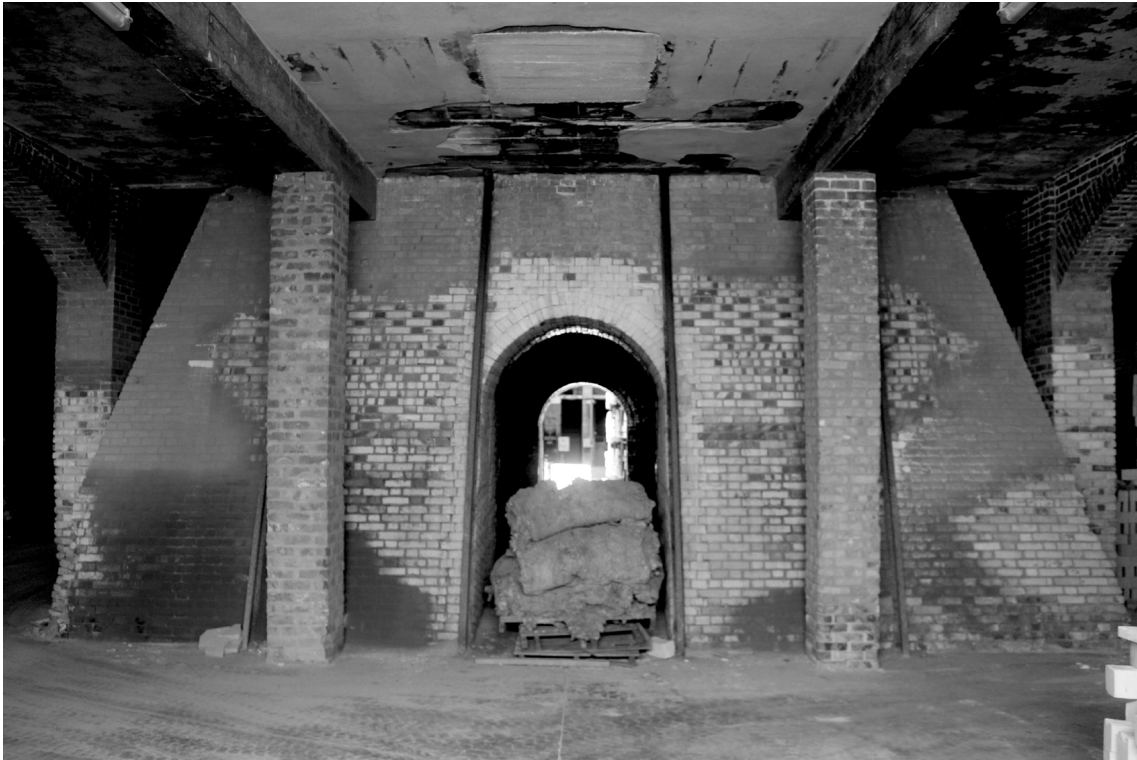
Fig. 3 | Único forno de grês presente atualmente na Fábrica Jerónimo Pereira Campos, Alvarães - Viana do Castelo
