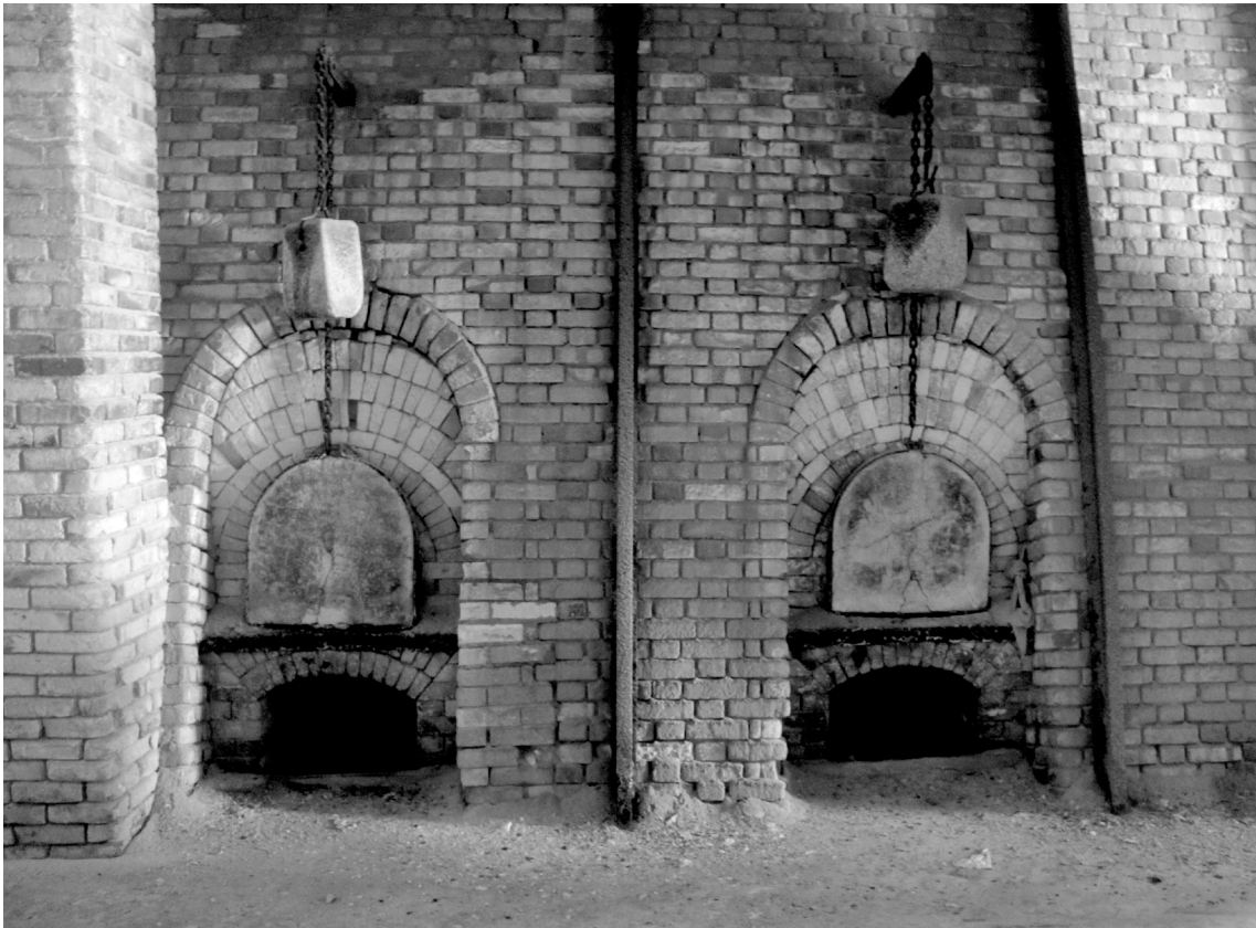
Fig. 4 | Único forno de grês presente atualmente na Fábrica Jerónimo Pereira Campos, Alvarães - Viana do Castelo
