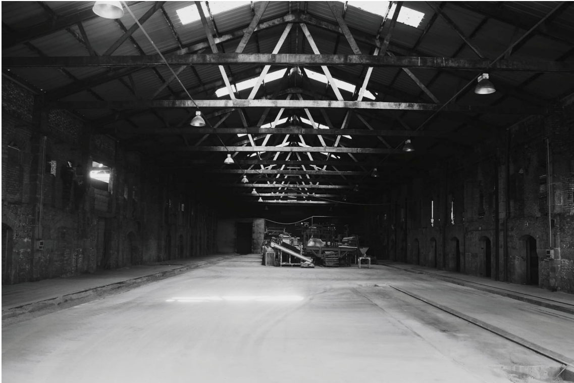
Fig. 63 | Fotografia do interior da Fábrica Jerónimo Pereira Campos, Alvarães antigo setor do forno francês (PISO RÉS DO CHÃO)
