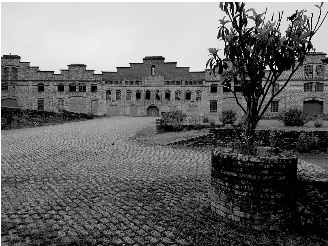
Fig. 50 | Fachada Principal Poente - Fábrica Jerónimo Pereira Campos em Alvarães, Viana do Castelo
