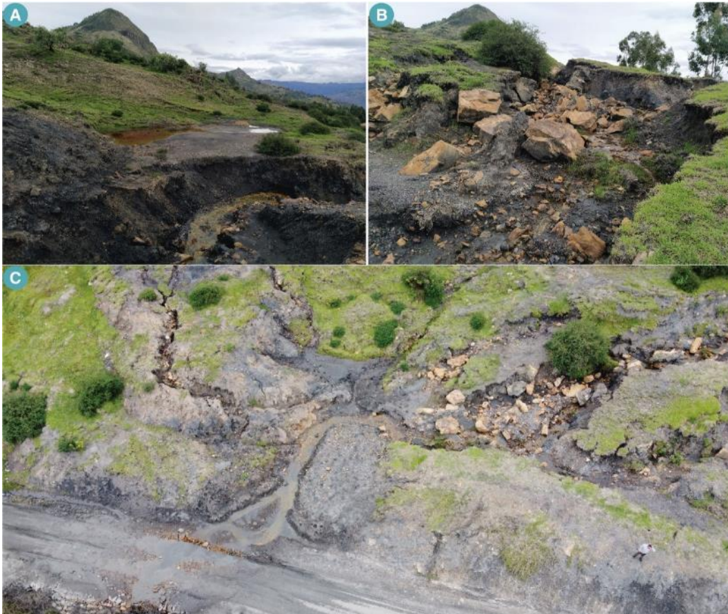
Figura 18: A: Se observa el entrapamiento de aguas en el cuerpo del deslizamiento, B) y C), Se aprecia la escorrentía superficial de aguas provenientes de la quebrada que saturan el terreno.
