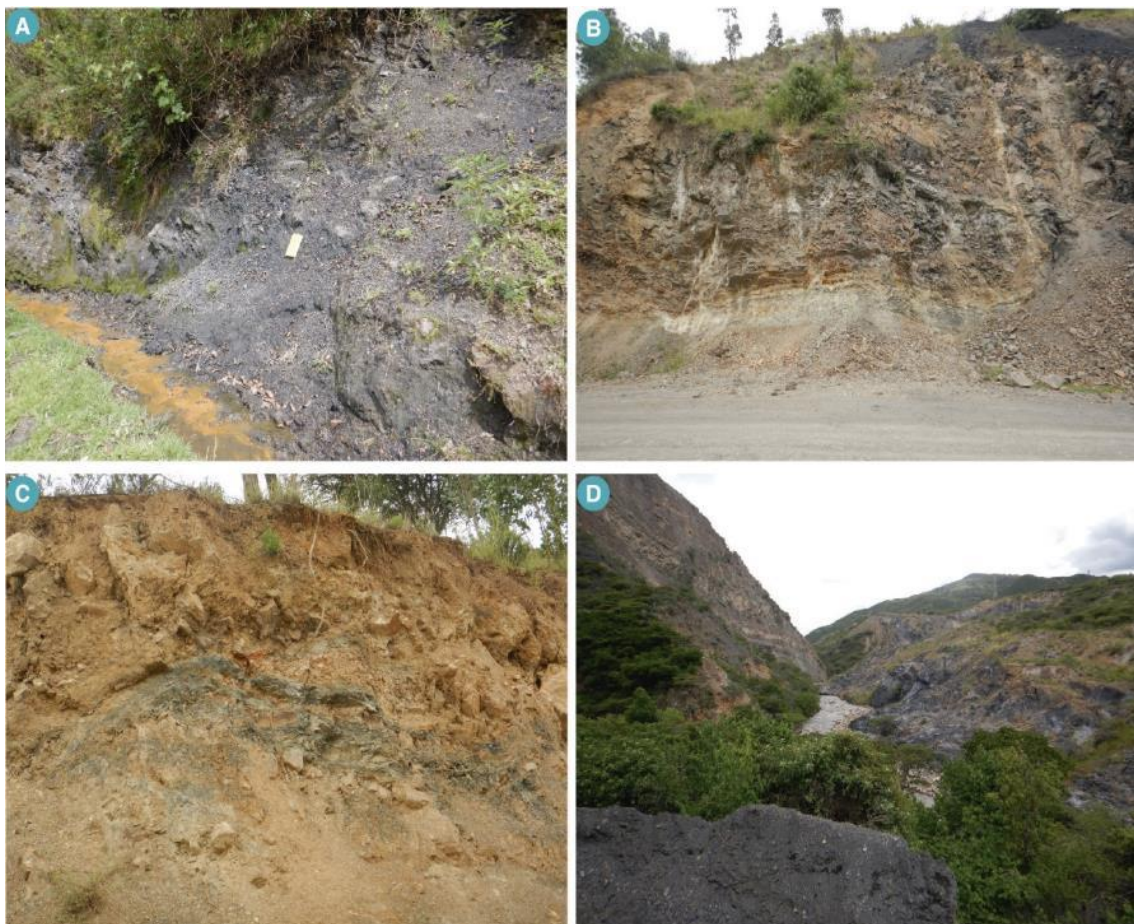
Figura 03. Muestra: A). Lutitas negras pizarrosas, altamente fracturadas y meteorizadas de la Formación Chicama; B) Intercalación de areniscas y lutitas en el corte de carretera Socosbamba-Piscobamba, las areniscas se encuentran fracturadas y altamente meteorizadas; C) lutitas pizarrosas deleznales cubiertas por suelos coluvio-deluviales conformados por bloques de areniscas (~1 m, de diámetro) envueltos en una matriz limoarcillosa plástica y cohesiva; D) areniscas de la Formación Chicama en la margen derecha del río Pomabamba.
