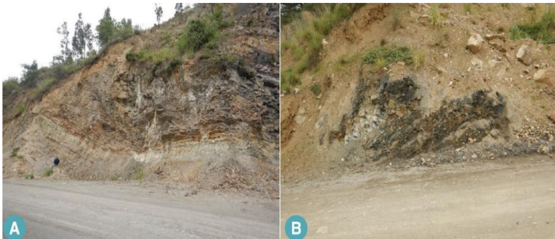
Figura 19: Vista de secuencias de areniscas y lutitas negras de la Formación Chicama, en el corte del talud de carretera, B: Se aprecia secuencias de lutitas negras cubiertas por depósitos coluviales de derrumbes.
