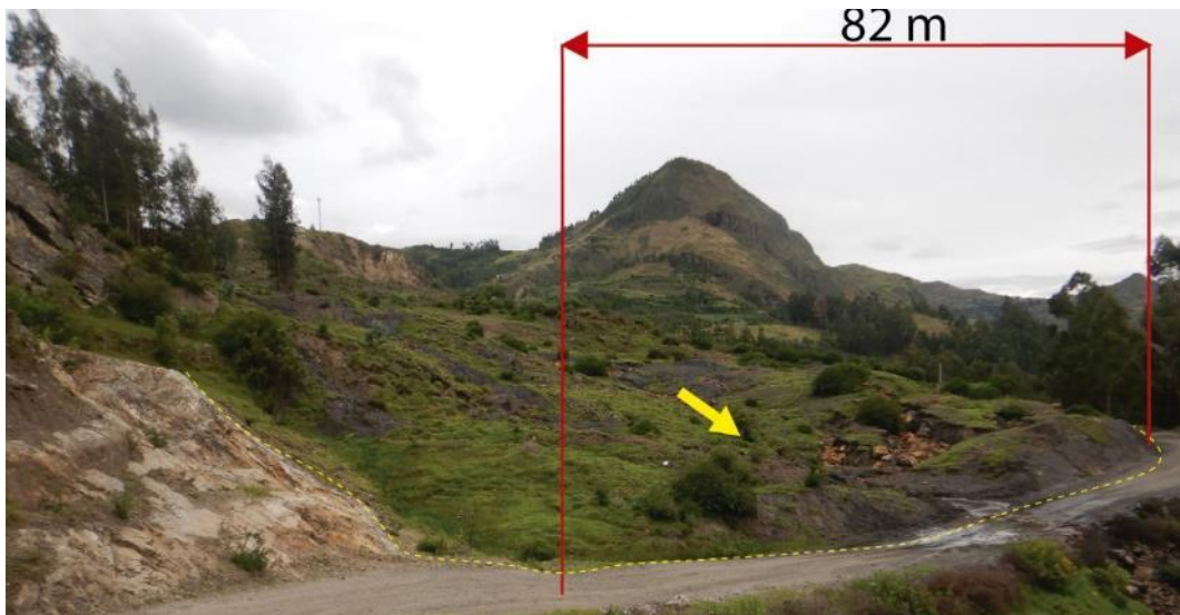
Figura 16: Se observa tramo de carretera Socosbamba-Piscobamba, afectada por deslizamiento. La base de la carretera antes erosionada, fue reconstruida.
