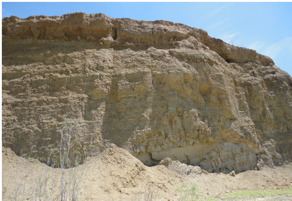
Fotografía 3.15 Intercalación de areniscas de grano medio con lutitas gris verdosas de la Formación Verdún. Vista al norte de la quebrada Faiquillal
