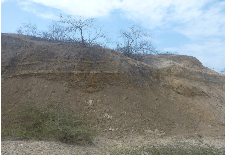
Fotografía 3.16 Lutitas intercaladas con limolitas de la Formación Chira en la quebrada Cerro Negro de la localidad de Totorá
