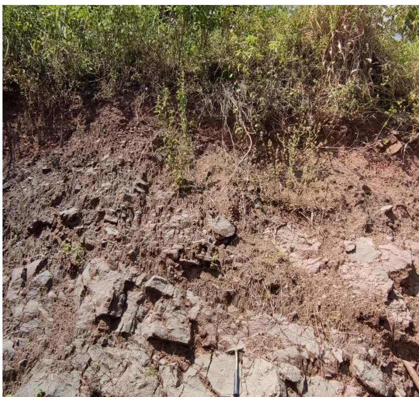
Fotografía 2. Muestra de los suelos coluvio-deluviales de la zona sobre los macizos rocosos de la Fotografía 1.
