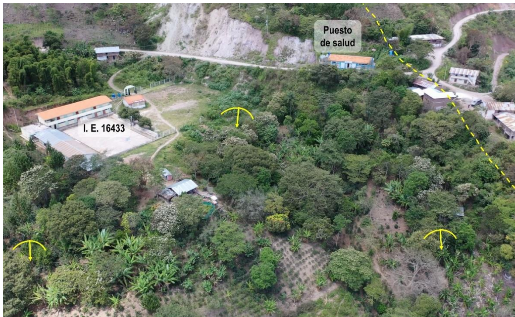
Figura 9. Vista del cuerpo central de la zona de reptación, donde se aprecia la institución educativa y puesto de salud afectados.
