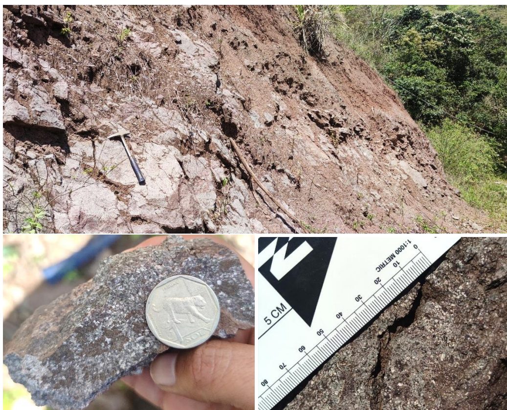
Fotografía 1. Vista de un talud donde se deja al descubierto al macizo rocoso de andesíticas muy fracturadas y altamente meteorizadas. Ubicación: E: 762821; N: 9316604; Z: 1534
