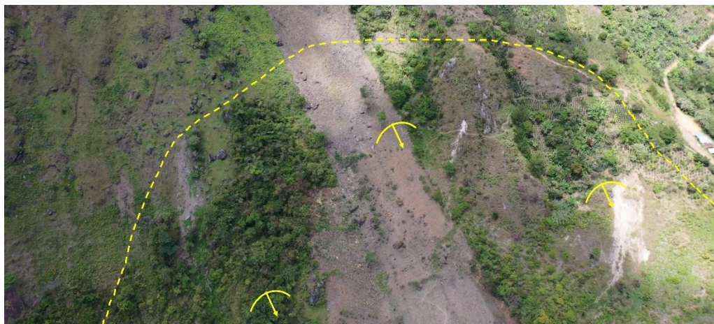
Figura 8. Vista de la parte alta del cuerpo de la zona de reptación de suelos.
