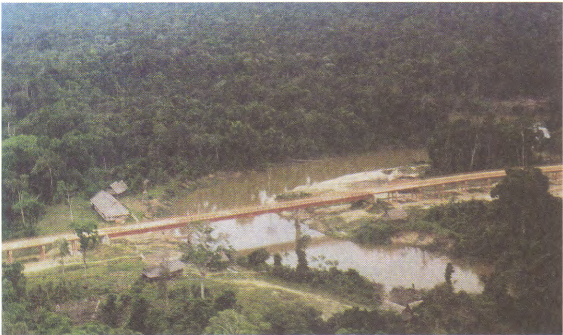
Foto N° 3.6 Puente Itaya, en la carretera Iquitos–Nauta. Nótese el poblado de Cahuide, asentado sobre las terrazas del río Itaya.
