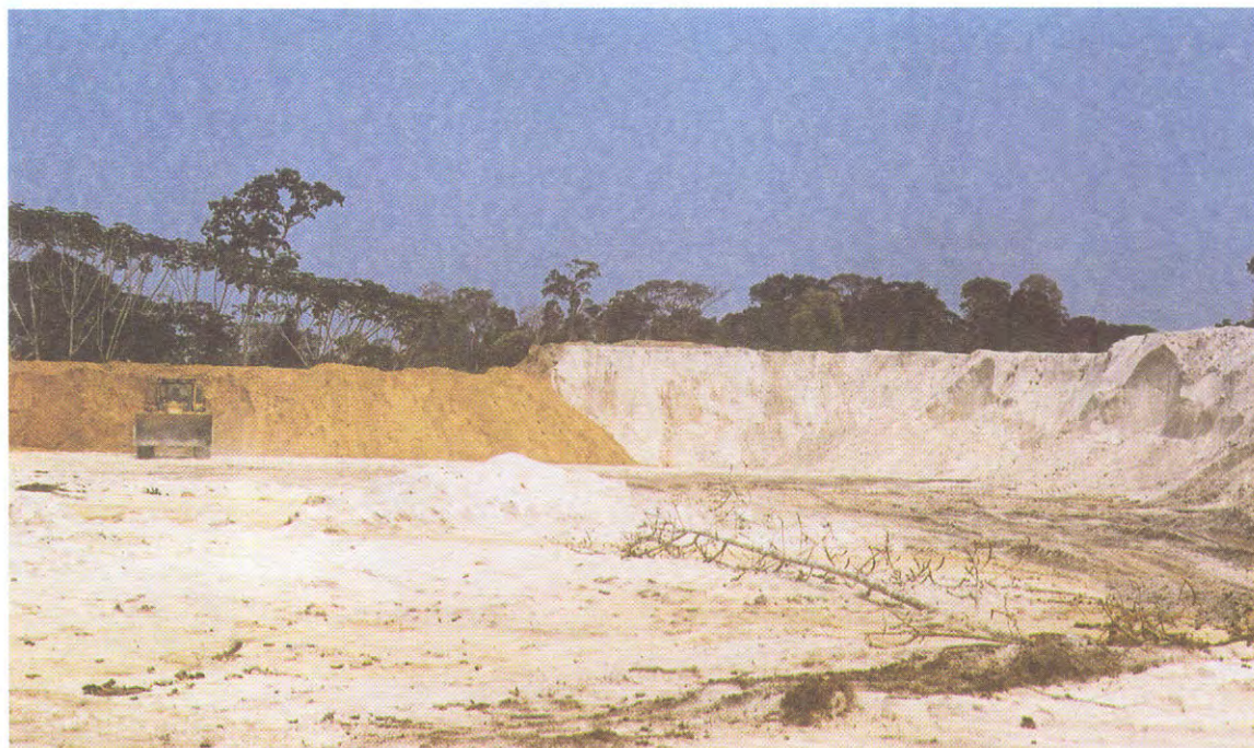
Foto N° 6.2 Vista parcial de la cantera 13 de Febrero, ubicada en el sector del mismo nombre, Iquitos.
