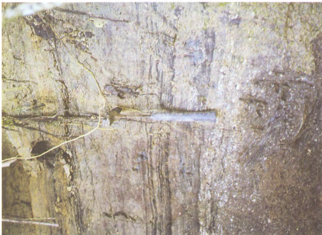
Foto N° 4.5 Limoarcillitas gris verdosas a plomizas fosilíferas, nivel medio de una sección de la Fm. Pebas, en las inmediaciones de la laguna Colombia, margen izquierda del río Yavari.
