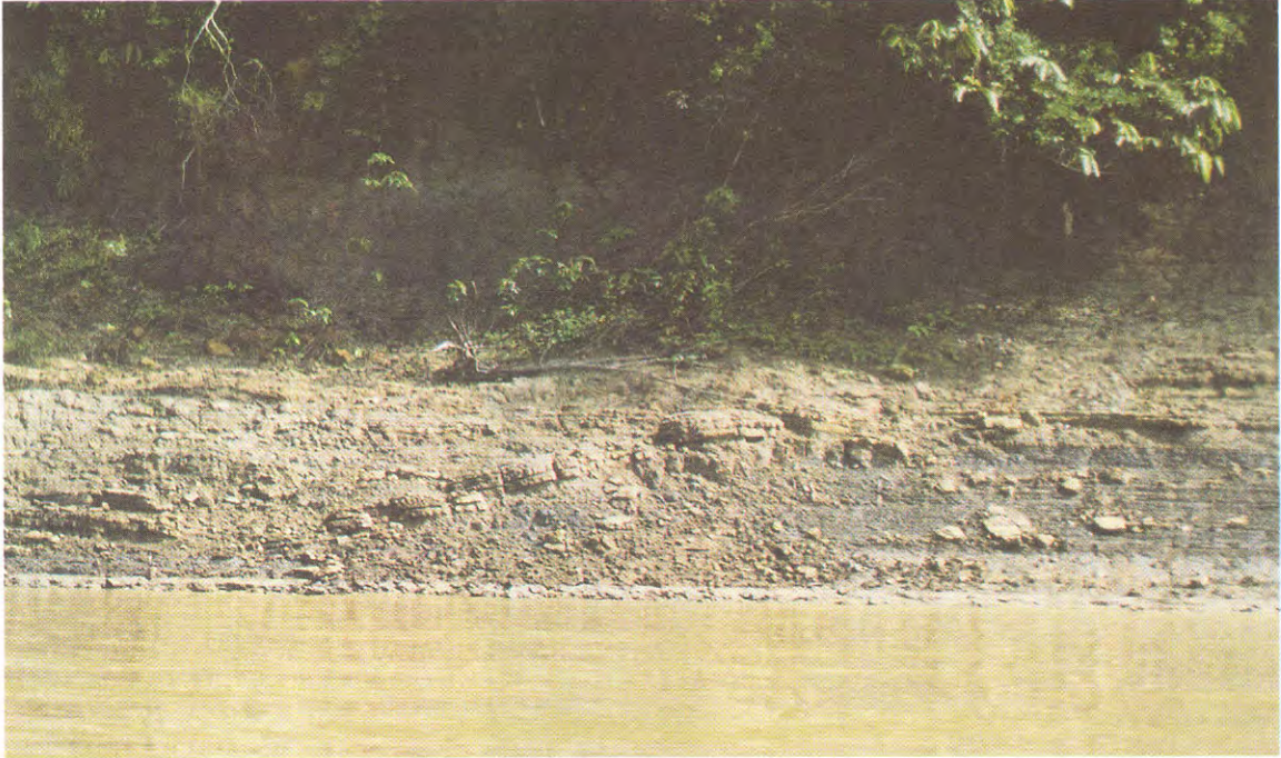
Foto N° 5.3 Falla normal afectando a la Formación Pebas, localizada en las proximidades de la Qda. Miraflores, río Yavarí (cuadrángulo de Buena Vista).
