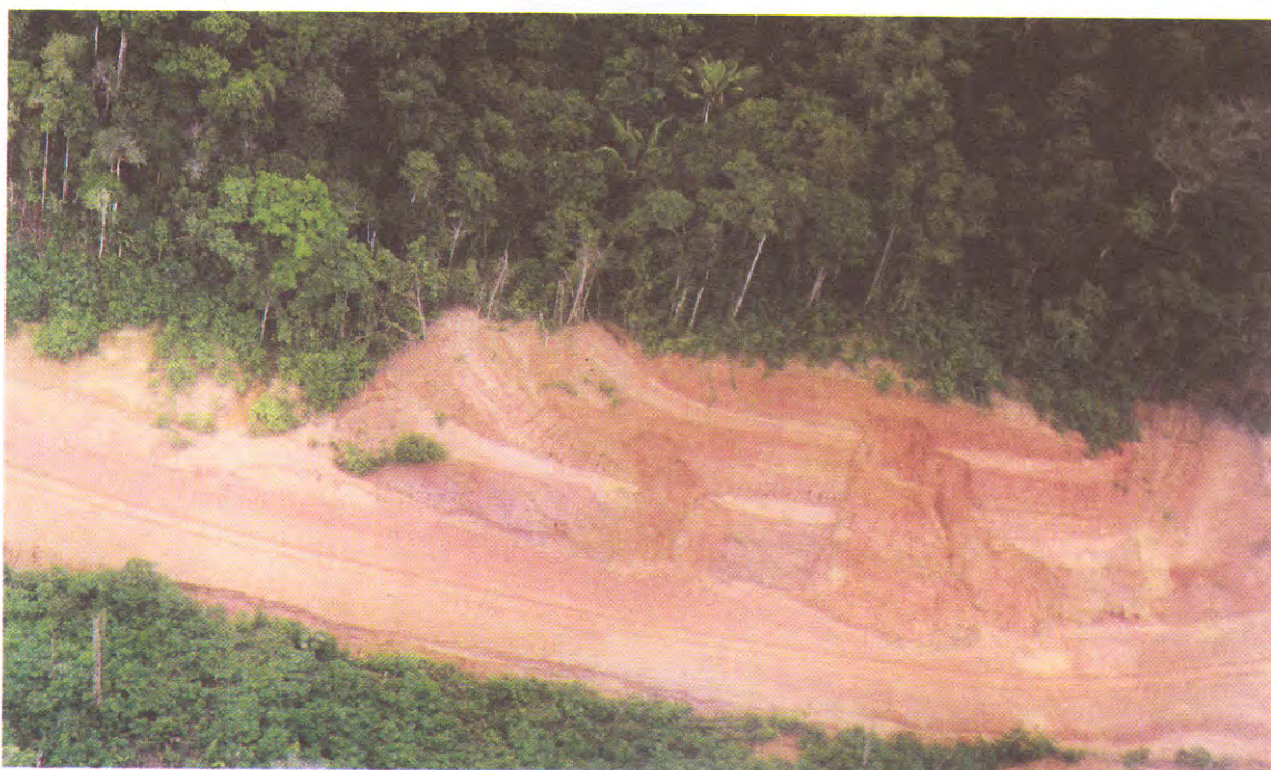
Foto N° 7.3 Colapso de un talud por sobresaturación de agua, carretera Iquitos-Nauta.
