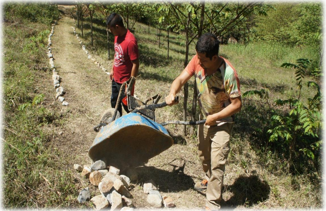
Empedrando el camino en la zona de Shambo.
