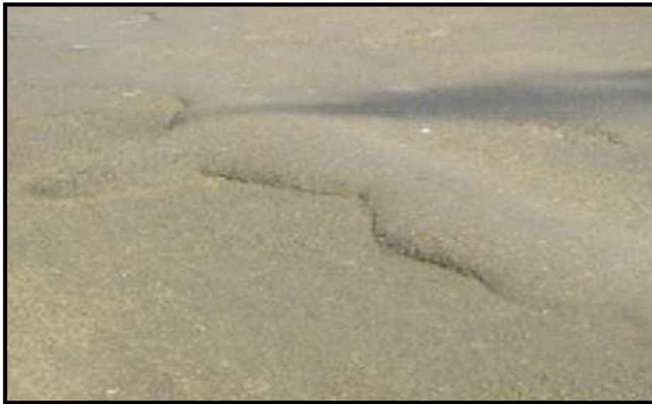
Figura 11. Ondulaciones de un pavimento flexible.
