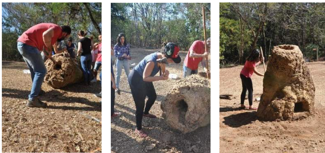
Figura 69: Construção do forno de cupinzeiro, ago./set. 2017. Fotos: Lílian Panachuk.
