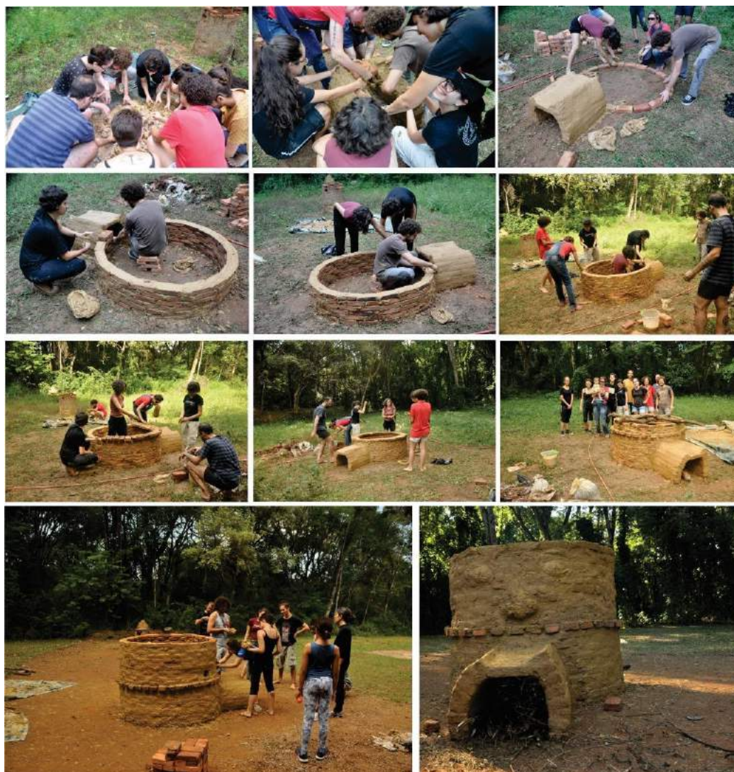
Figura 93: Construção da fornalha, Glória I, maio e junho de 2019. Fotos: Lílian Panachuk e equipe.
