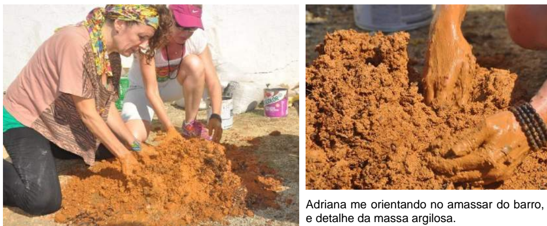
Figura 61: Preparo da argila para o forno. Fotos: Laila Kierulff.
