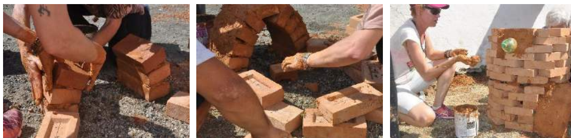
Figura 62: Etapas de construção do forno. Fotos: Laila Kierulff.
