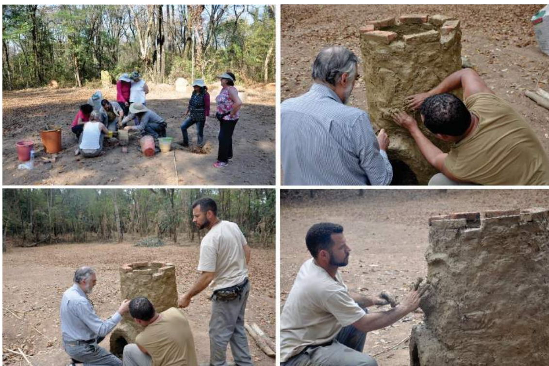
Figura 68: Construção do forno de tiragem direta, ago./set. 2017. Fotos: Lílian Panachuk.
