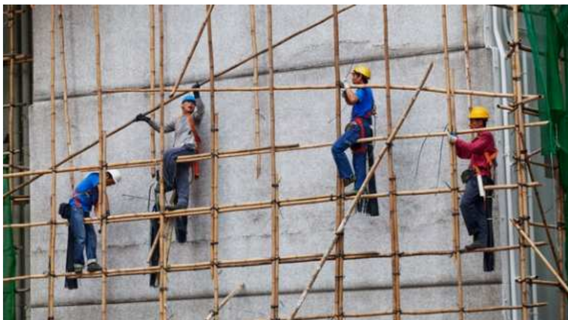
Figura 33: Andaime de bambu
