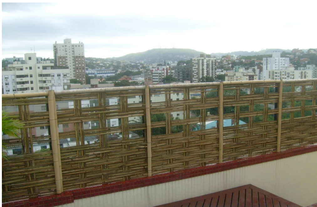
Figura 10: Acabamento de guarda corpo com taquara.
