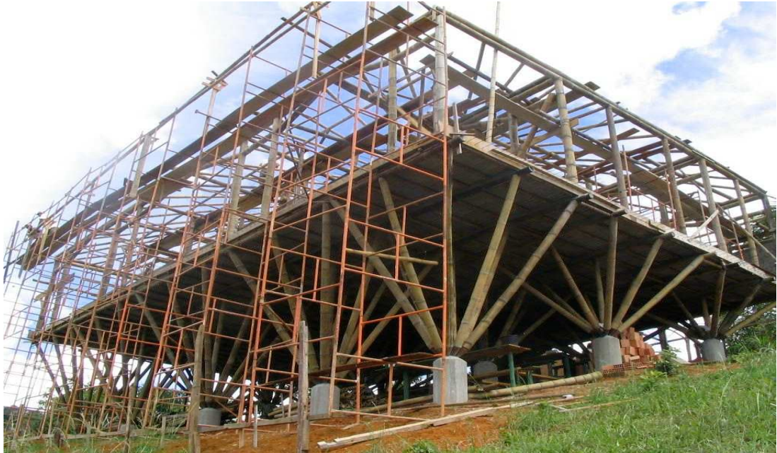
Figura 37: Casa estruturada em bambu ( http://arquitetando-sustentabilidade.blogspot.com.br )
