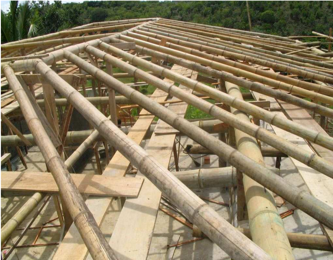
Figura 40: Engradamento ( http://cmarconstrucoesalternativas.com )
