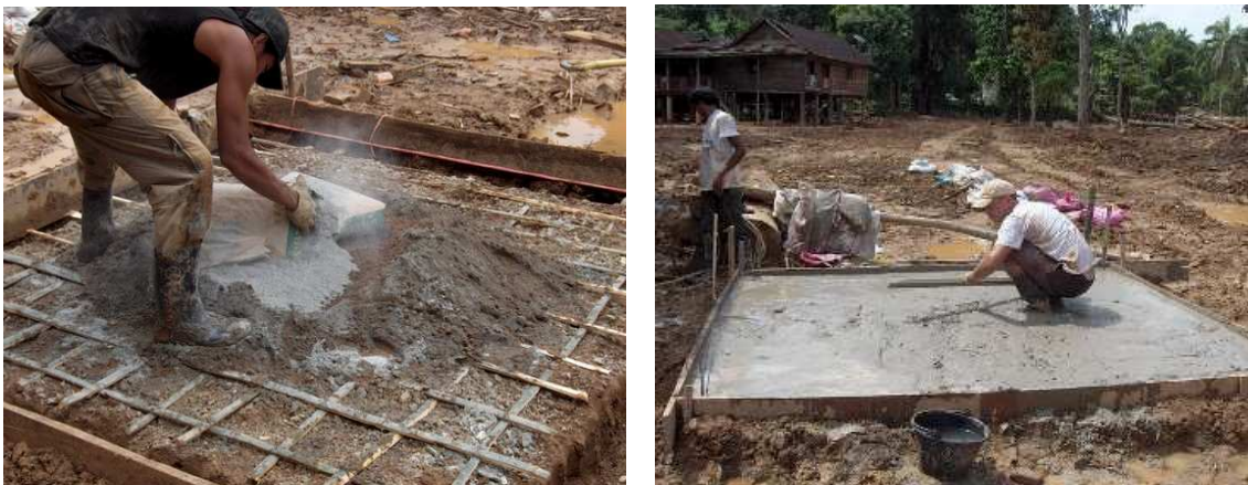
Figura 34: Laje com armação de bambu
