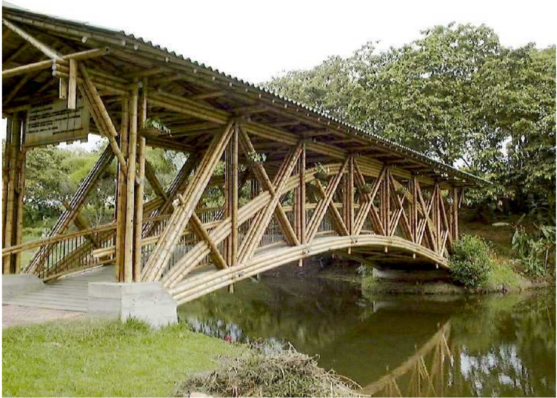
Figura 36: Pontilhão de bambu ( http://giodas.blogspot.com.br )
