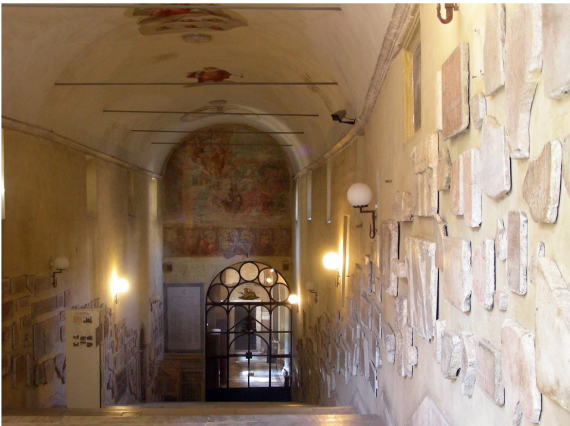
FIGURA 12 - ESCADARIA INTERNA DO COMPLEXO DE SANT'AGNESE, VISTA DE CIMA. EMBAIXO, A PORTA DE VIDRO QUE DÁ ACESSO À NAVE. FONTE: WIKIMEDIA COMMONS. PÚBLICO. DISPONÍVEL EM: < HTTPS://COMMONS.WIKIMEDIA.ORG/WIKI/FILE:ROMASAGNESESCALAACESSO.JPG >. ACESSO EM 13/08/2015.
