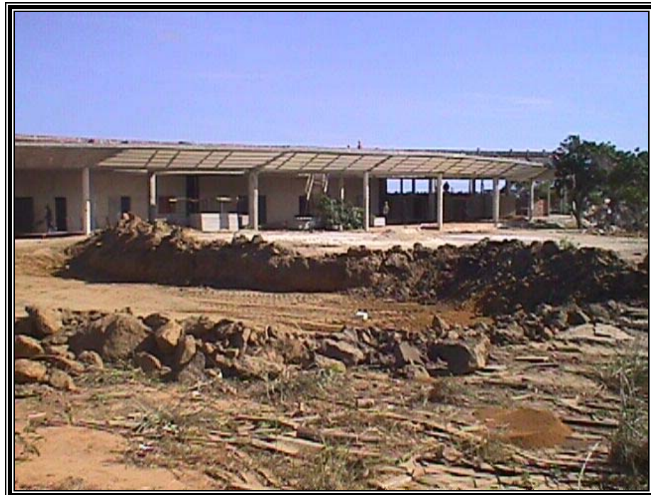
Figura 12: Vista geral da Área I do Sítio Arqueológico do Campo durante a realização da terraplanagem para instalação dos jazigos do Cemitério Morada da Paz. Paulista-PE.
