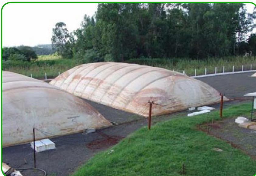
**Figura F.11.** Foto de um biodigestor com lona, para armazenar o CH<sub>4</sub>.
