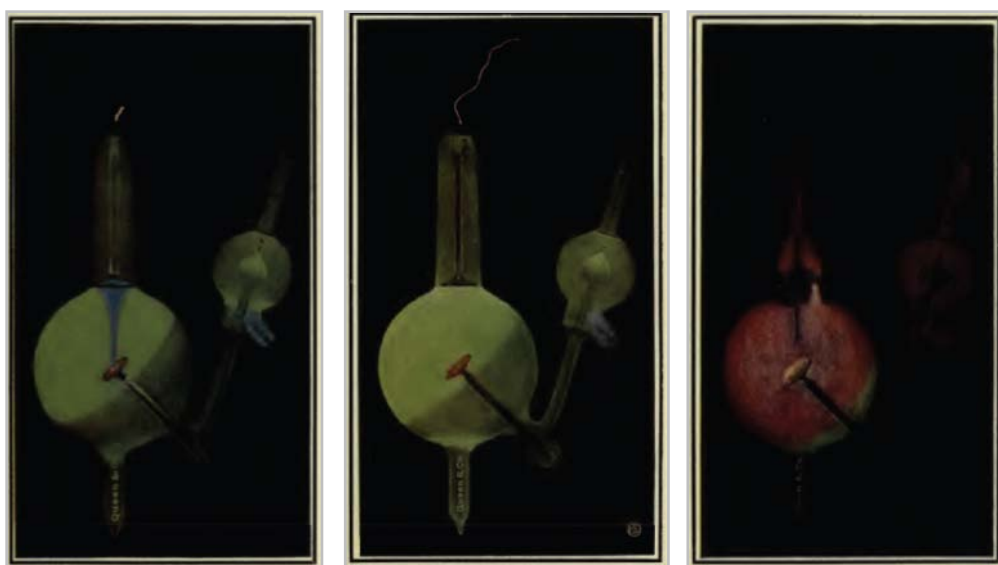
Figs. 122, 123 e 124: Coloração exibida pela fluorescência das paredes de um tubo de raios-X em condições de baixo vácuo, de vácuo adequado e perfurado, respectivamente. (KASSABIAN 1907)
