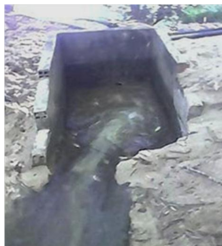
Figura 13 – Cisterna de escoamento da água para o rio Tocantins.
