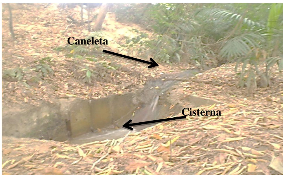
Figura 22 – Retorno da água das caixas de secagem ao rio
