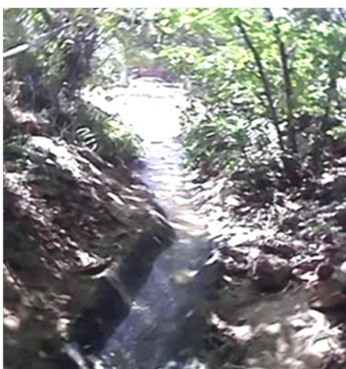
Figura 12 – Calha de escoamento da água das caixas de secagem
