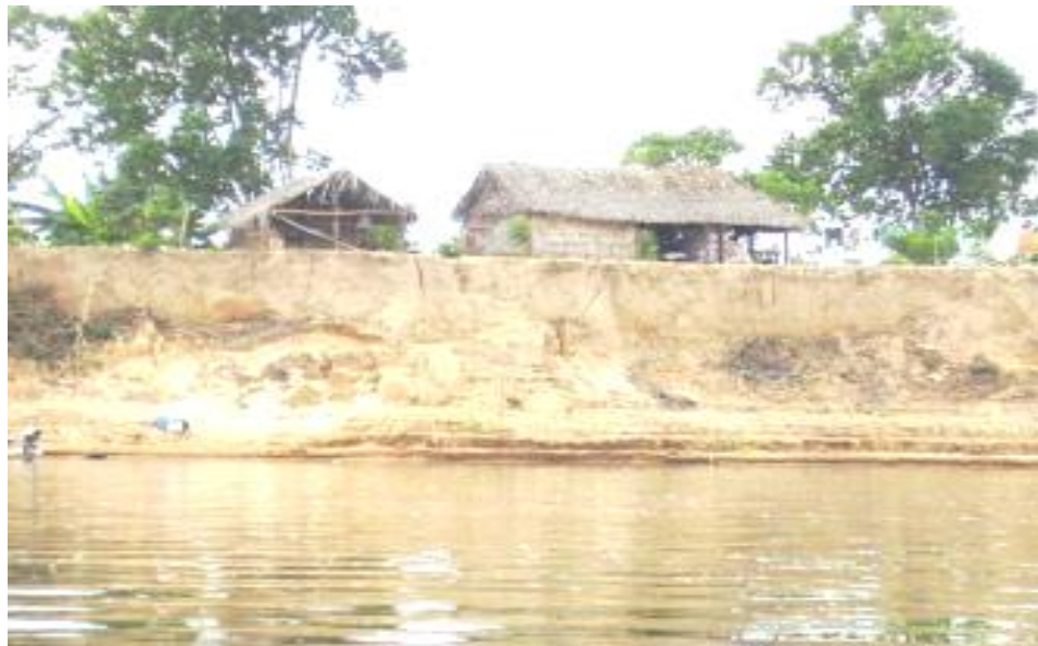
Figura 15 – Evidência do desmatamento da mata ciliar á margem do Rio Tocantins, Fonte: www.progresso-ma.com.br
