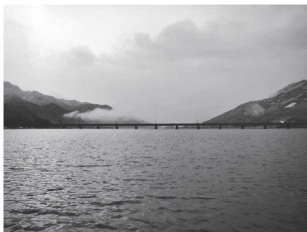
雪景色の由良川河口。北近畿タンゴ鉄道由良川鉄橋はさしずめ現代版「由良の渡」
