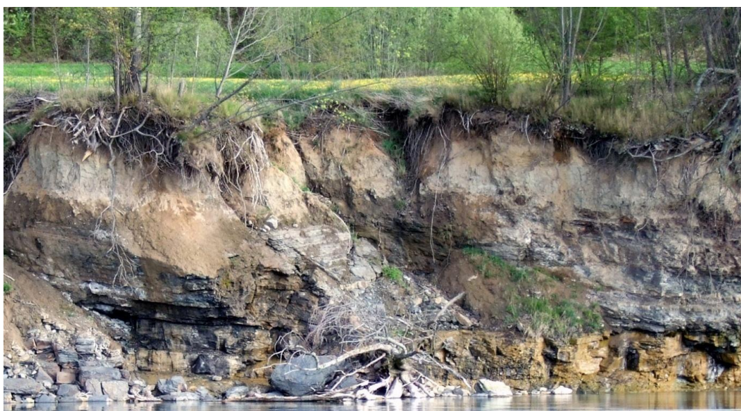
Fig. 62. Nyligen rasad, ca 7 m hög klint i Visingsöformationen, sedd från båt ca 1 km norr om undersökningsområdet, med gulgrå sandsten som överlagras av mörk skiffer. Det ca 3 m mäktiga jordlagret består av tunn lerig grå urbergsdomierad morän under ca 2 m ljusgrågul lerig skiffer/sandstensdominerad morän. Någon meter svallsand överlagrar.
