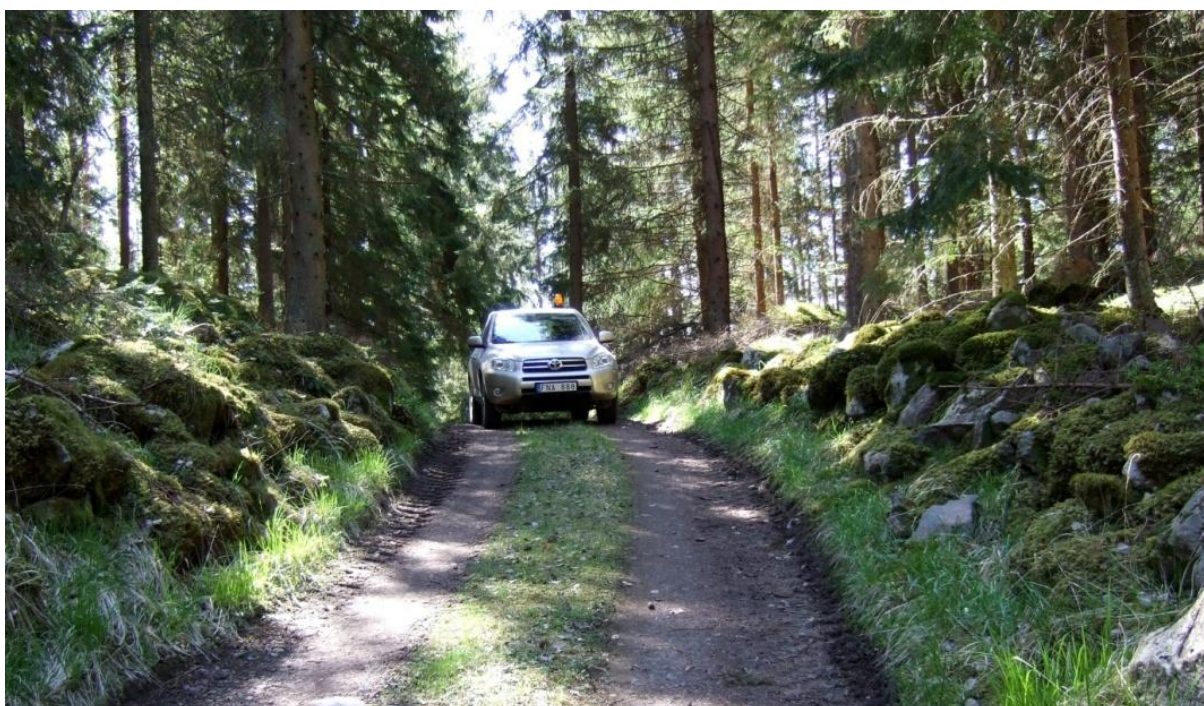
Fig. 56. Vägen är kantad med från berggrunden lokala kärnblock som grävts fram ur korttransporterad morän vid schaktningen av grusvägen. Bilden tagen mot söder.
