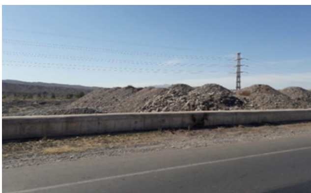
Figura 39: Rechazo y escombros depositados en lecho río
