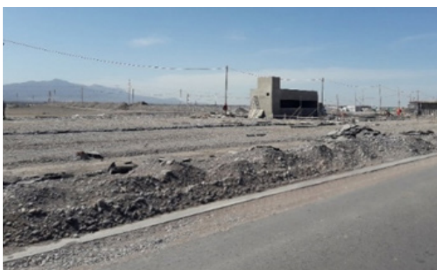
Figura 37: Nivelación y primeras construcciones
