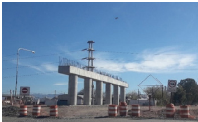
Figura 5: Inicio de puente en calle Oro
