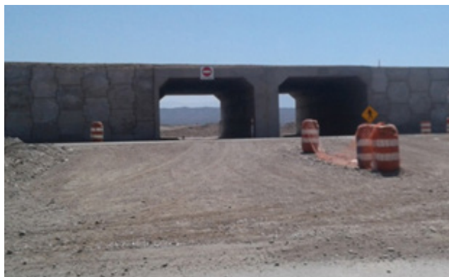
Figura 3: Puente de calle Centenario con bajada y lateral
