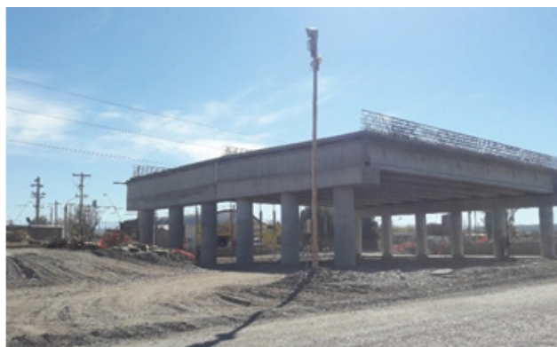
Figura 6: Puente ensamblado en calle Oro
