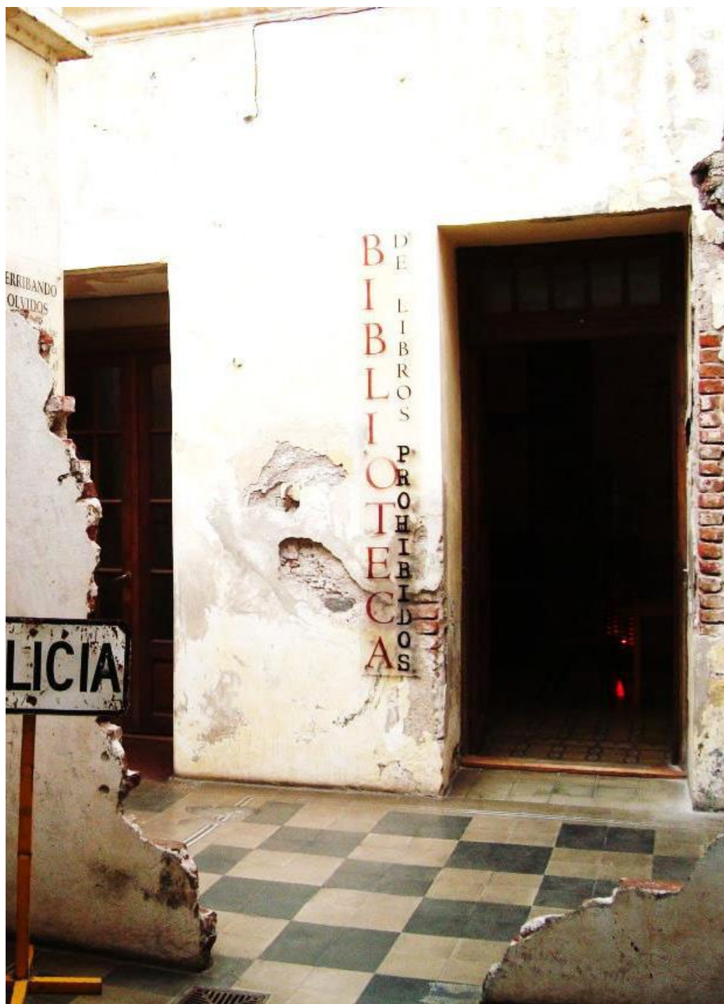
Muro derrubado para revelar espaços do ex-”D-2” (Foto: Elson Silva, Acervo pessoal)
