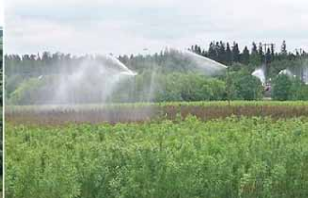
Figura 7. Sistema de fitorremediación que utiliza una plantación de 75 hectáreas de sauces en Enköping, Suecia. Planta de tratamiento de aguas residuales (primer plano), piletas para almacenar las aguas en invierno (al fondo) y campos de sauces regados con efluentes de fangos. P. Aronsson
