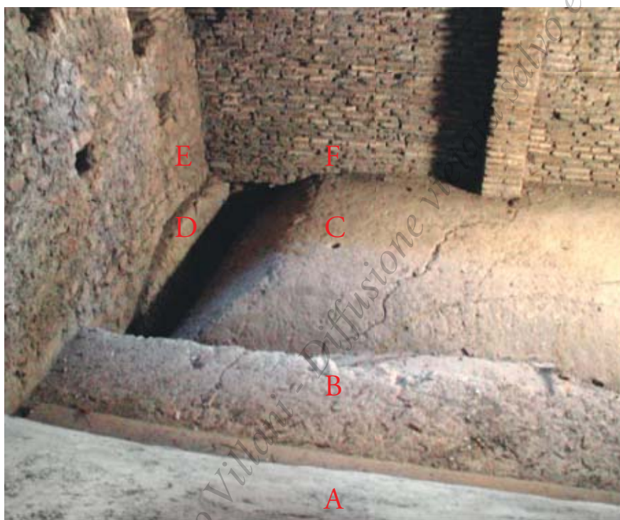
Fig. 91 - Colonnato di S. Pietro. Portico meridionale. Sottotetto, estradosso di una volticella della campata laterale. Ai lati, sono visibili gli archi sui quali si impostano i muri radiali (foto dell'A.)
