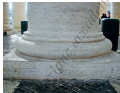
Fig. 128 - Colonnato. Portico settentrionale, dettaglio della base di una colonna. Si noti la numerazione nel plinto (foto dell'A.)
