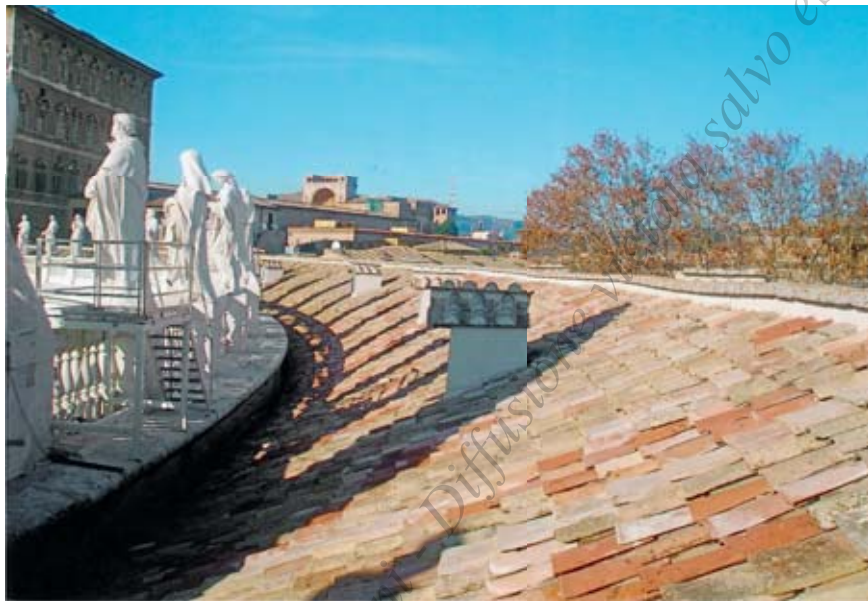
Fig. 73 - Colonnato di S. Pietro. Portico settentrionale. Copertura, particolare. Al centro, uno degli abbaini per dare luce ed aria al sottotetto (foto dell'A.)
