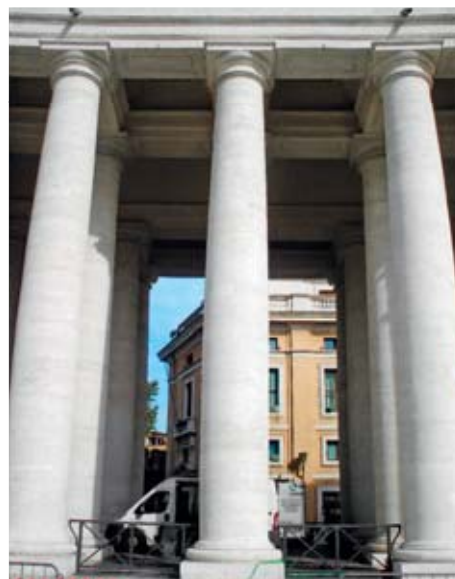
Fig. 48 - Colonnato di S. Pietro. Portico settentrionale. Colonne (foto dell’A.)
