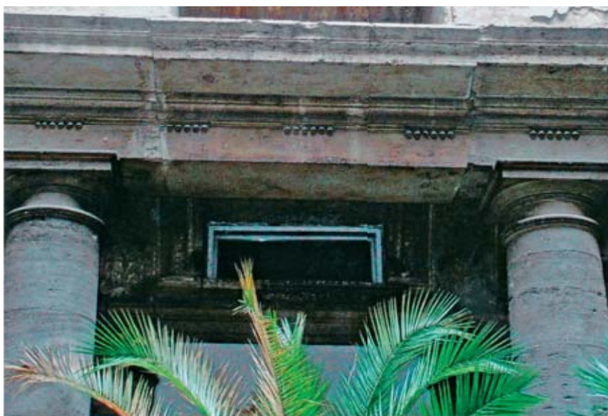
Fig. 130b - Roma. Palazzo Massimo alle Colonne. Cortile, portico, prospetto settentrionale. Dettaglio della trabeazione. Rispetto al precedente, il settore centrale dell'architrave presenta dimensioni maggiori (foto dell'A.)
