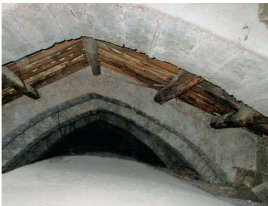
Fig. 77 - Colonnato di S. Pietro. Portico settentrionale. Sottotetto, archi trasversi. Sono visibili gli arcatecci incastrati nei muri degli archi; in basso, l'estradosso della volta a botte della corsia centrale (foto dell'A.)
