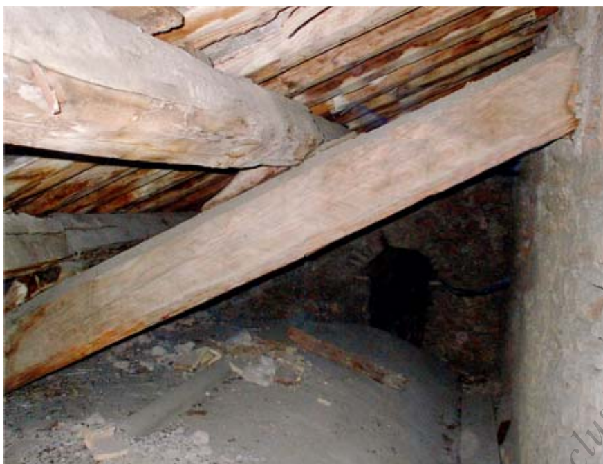
Fig. 75 - Colonnato di S. Pietro. Portico settentrionale. Sottotetto, particolare del vano in corrispondenza di una campata laterale. In fondo, aperto da un passaggio centinato, il muro radiale in asse con le sottostanti colonne; in primo piano, al centro, l'estradosso della volta della campata; in alto, una trave, frutto di un intervento successivo, che contribuisce a reggere un arcareccio incastrato nei muri radiali, sul quale sono poggiati a loro volta i travicelli. A destra, il muro di separazione con il vano corrispondente alla corsia centrale (foto dell'A.)
