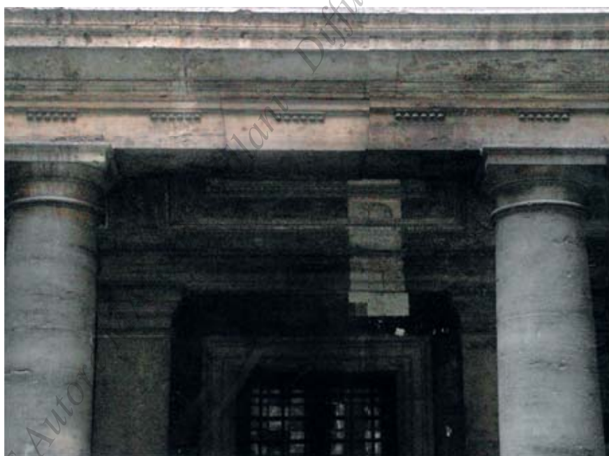
Fig. 130a - Roma. Palazzo Massimo alle Colonne. Cortile, portico, prospetto meridionale. Dettaglio della trabeazione. Al centro, è visibile l'architrave di tre pezzi (foto dell'A.)
