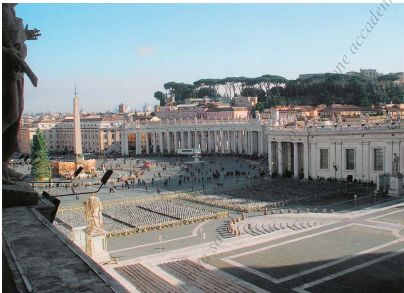
Fig. 34 - Colonnato di S. Pietro. Portico meridionale. Sulla destra, l'attacco con il Corridore o Braccio di collegamento con la basilica (foto dell'A.)
