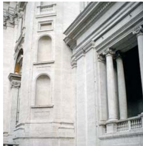
Fig. 36 - Colonnato di S. Pietro. Dettaglio della connessione tra il Corridore meridionale (Braccio di Carlo Magno) e la facciata della basilica (foto dell'A.)
