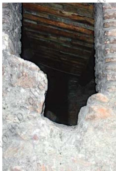
Fig. 91 - Colonnato di S. Pietro. Portico meridionale. Sottotetto, estradosso di una volticella della campata laterale. Ai lati, sono visibili gli archi sui quali si impostano i muri radiali (foto dell'A.)
