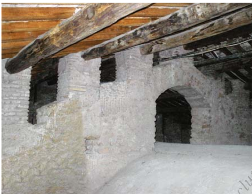
Fig. 89 - Colonnato di S. Pietro. Portico meridionale. Sottotetto, particolare dei muri radiali con l'arco di raccordo, verso la volta centrale (foto dell'A.)
