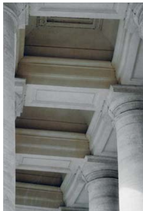
Fig. 67 - Colonnato di S. Pietro. Portico settentrionale. Volte a schifo di una corsia laterale (foto dell'A.)
