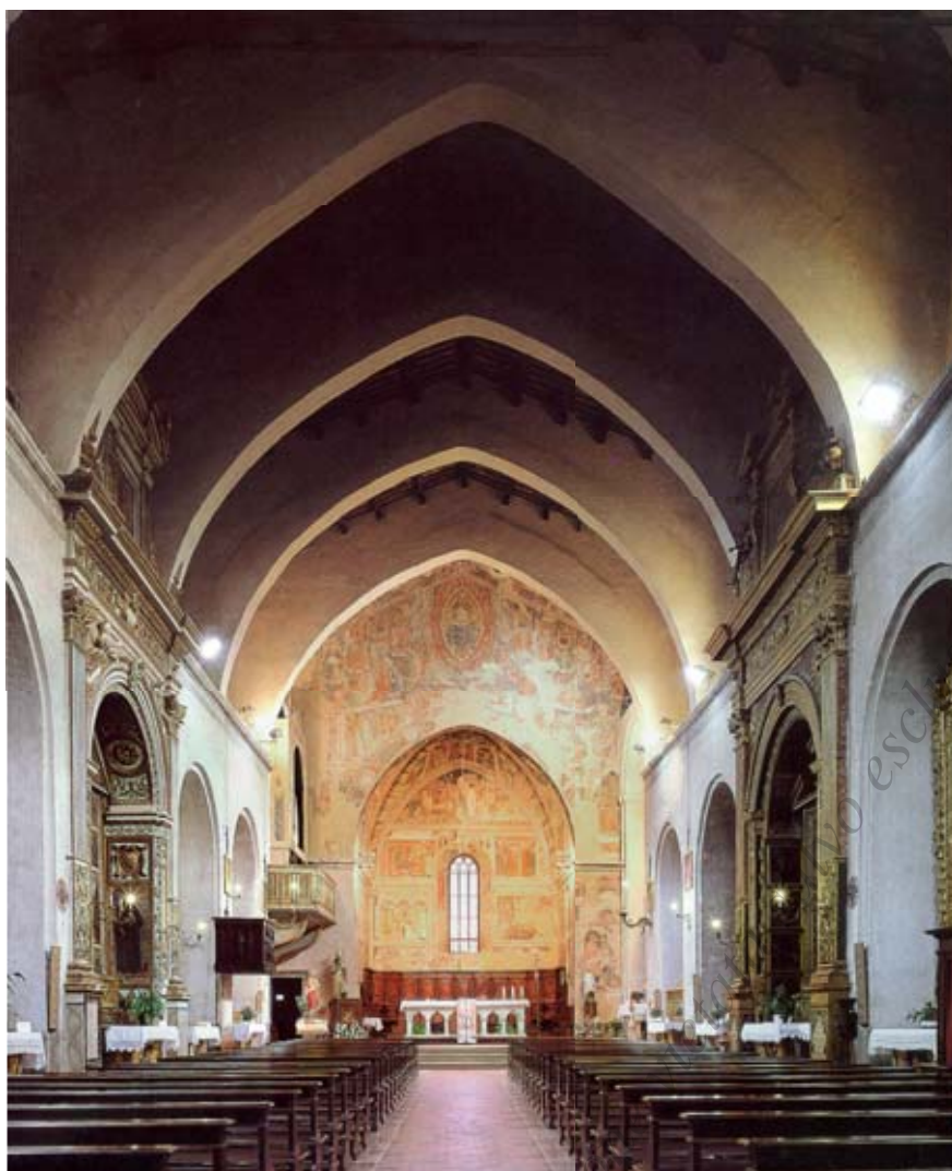
Fig. 87 - Gubbio. S. Agostino. Interno. Si noti il sistema strutturale di sostegno della copertura risolto grazie ad archi diaframma
