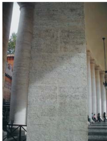
Fig. 52 - Colonnato di S. Pietro. Portico settentrionale. Colonna, dettaglio. È visibile l'alternanza tra un blocco singolo e due semiblocchi con giunto verticale (foto dell'A.)
