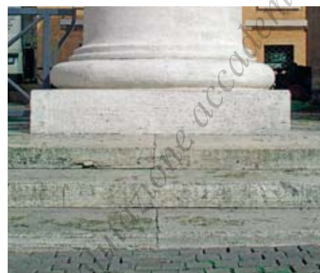
Fig. 10 - Colonnato di S. Pietro. Portico settentrionale, dettaglio degli scalini (foto dell'A.)
