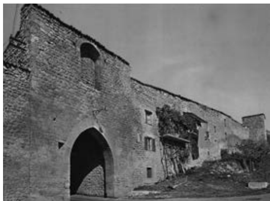
Norcia. Porta Orientale prima del restauro (1979)
