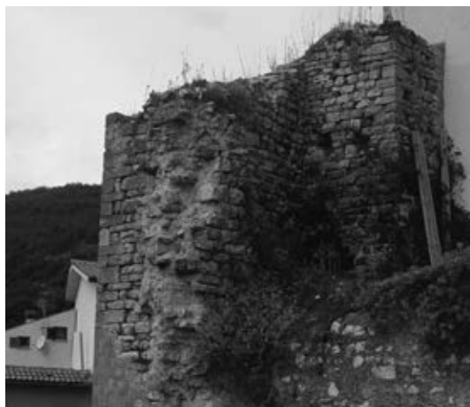
Cortigno. Resti dell'antica torre
