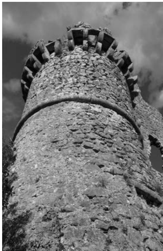
Ferentillo, particolare della torre d'angolo nella rocca di Matterella
