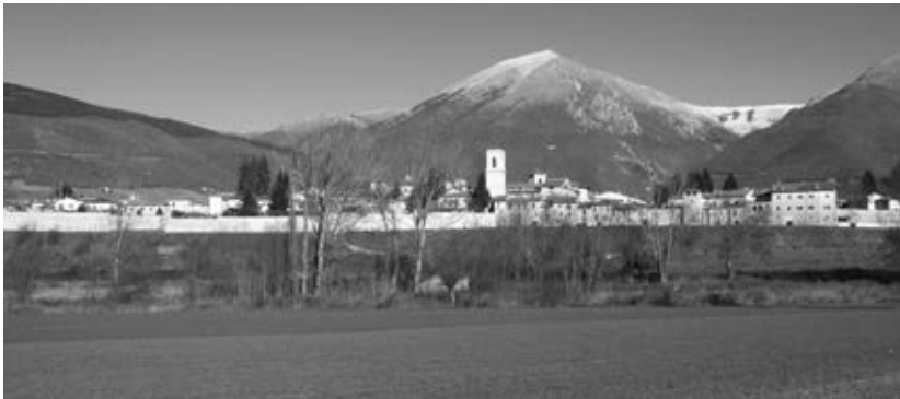
Norcia. Particolare della cinta muraria
