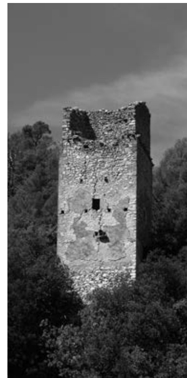
Collestatte. Torre d'avvistamento
