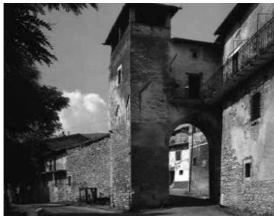
Norcia. Porta del Colle prima del restauro (1979)
