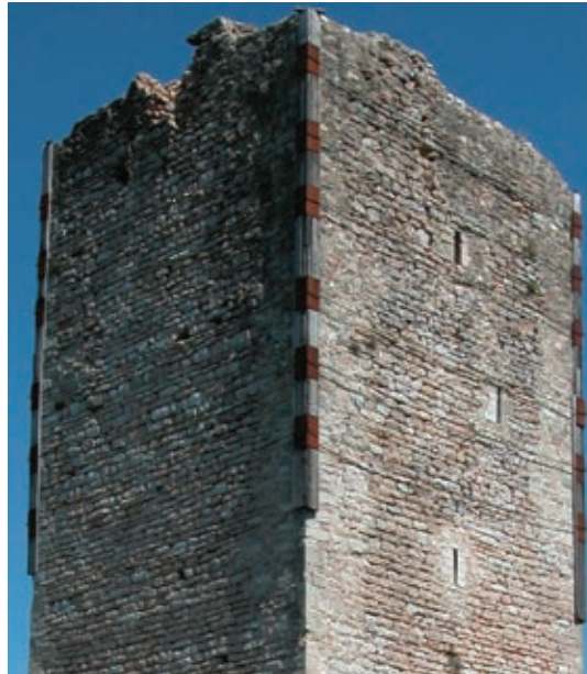
Poggio di Croce, particolare della torre
