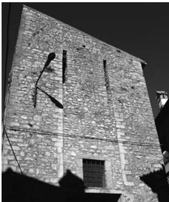
Meggiano, la torre di accesso al castello, oggi notevolmente alterata
