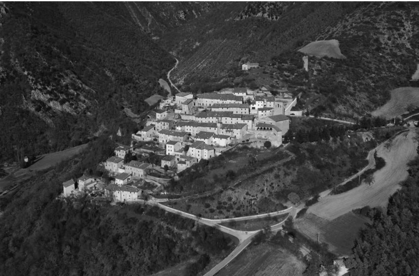
Campi Alto. Veduta aerea del borgo
