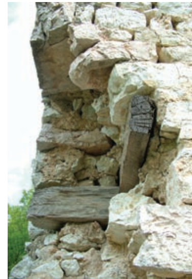
La torre di Onde. Onde, particolare dei pali radice inseriti nella muratura
