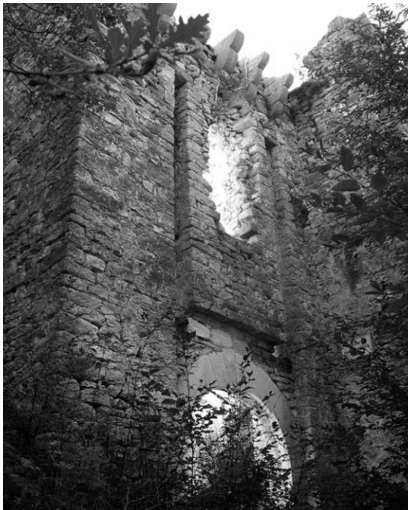
Geppa, particolare della struttura fortificata
