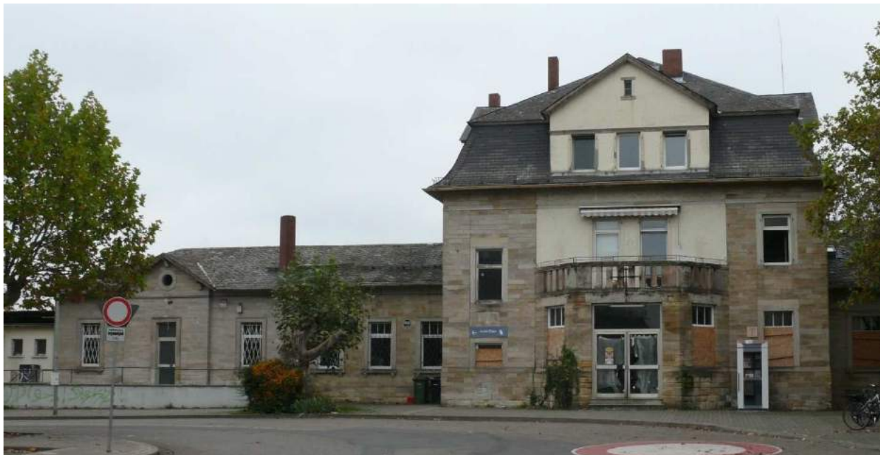
Abbildung 52: Blick auf das Bahnhofsgebäude mit Vorplatz, zukünftig Teil der Nord-Süd-Trasse parallel zur Bahn
