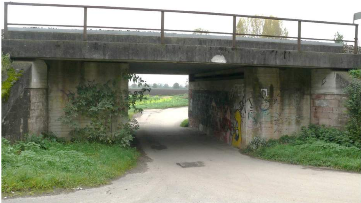
Abbildung 53: Gleisunterquerung Holländergraben aus Richtung Osten
