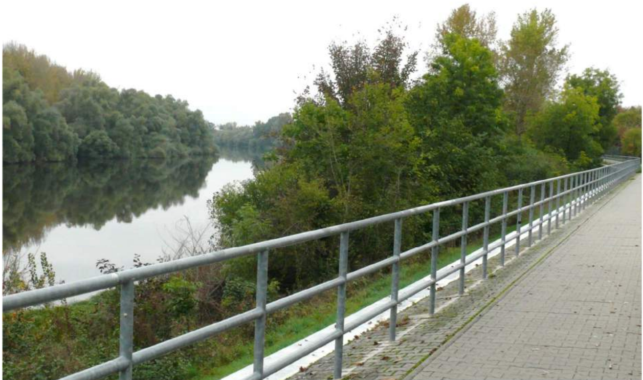
Abbildung 44: Aktuelle Situation am Altrheinuferweg
