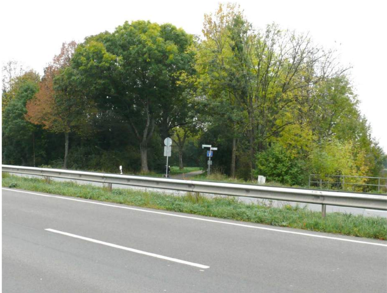
Abbildung 46: Blick von Westen auf den Weg entlang des Holländergrabens an der B 44
