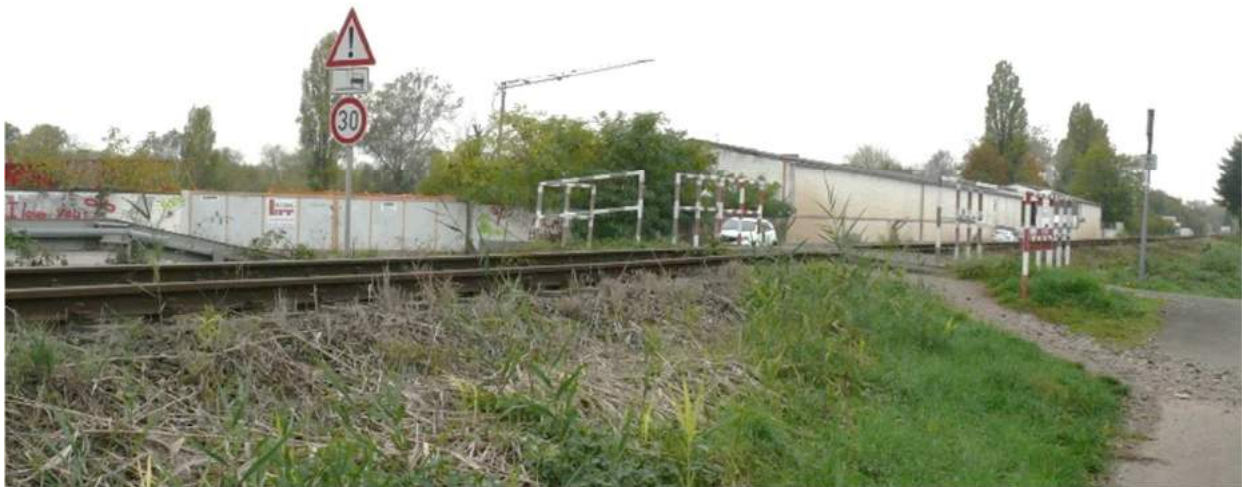
Abbildung 48: Blick auf die Querung Rosenaustraße / Industriegleis aus Richtung Osten
