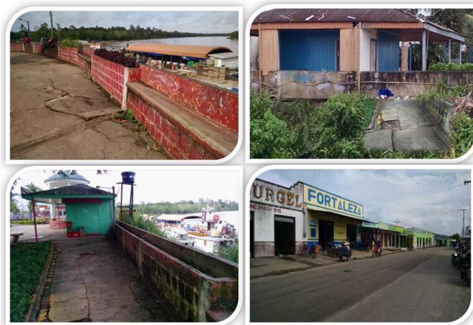
Figura 08 – Logradouros públicos e comércios sob pressão da convexidade do meandro do rio Tarauacá
