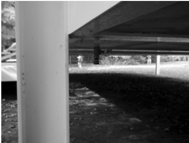
Estructura de acero
