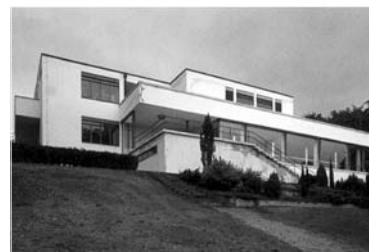
Imagen exterior de la casa Tugendhat.
