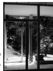
Vista de la carpintería. Casa Tugendhat.
