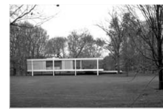
Ausencia de tratamiento vegetal en las fachadas.
