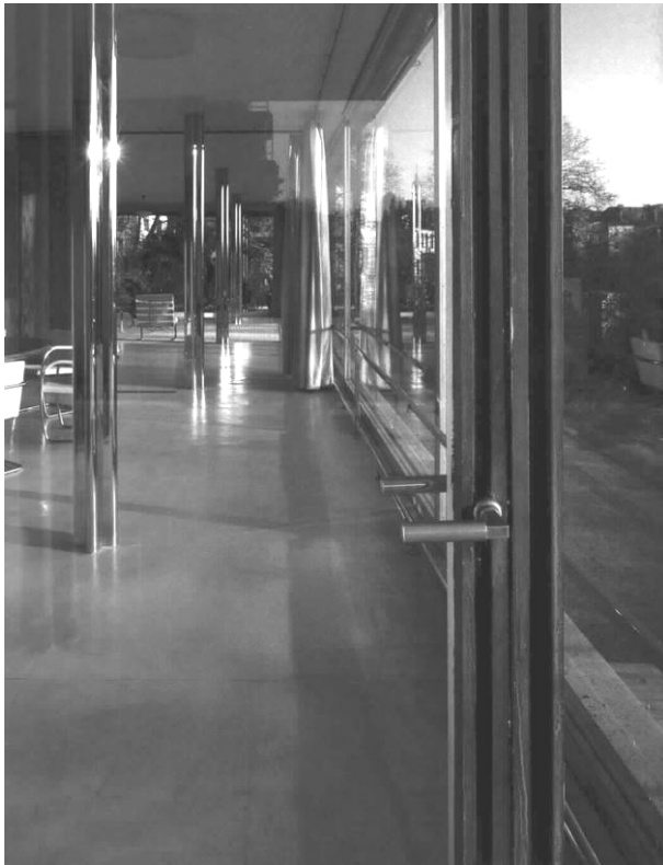
La estructura independiente del cerramiento.
