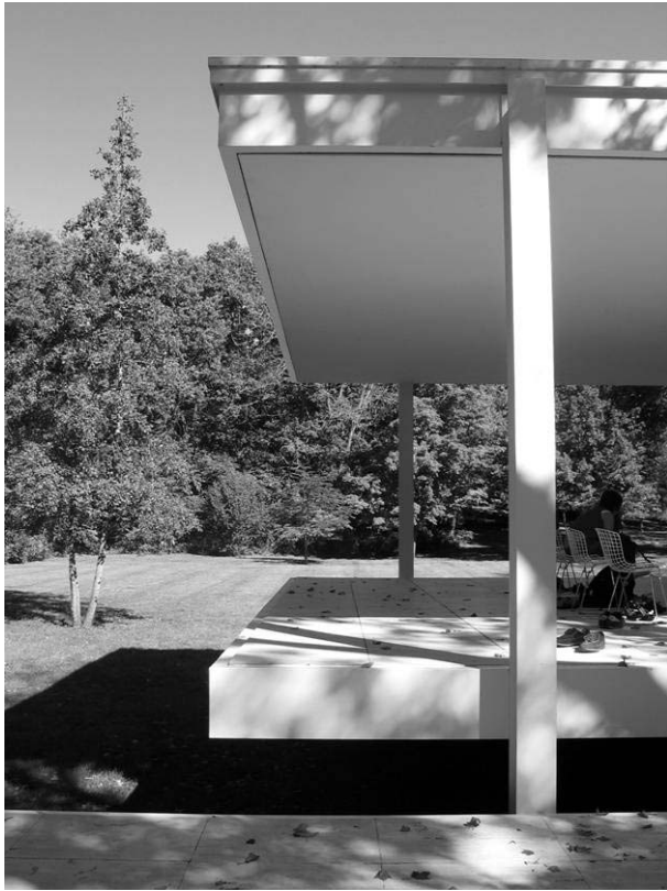
Estructura pintada de blanco
