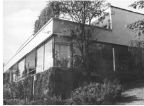
Abundante tratamiento vegetal (enredaderas y trepadoras) en las fachadas recayentes al jardín.
