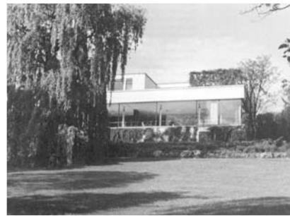
La casa Tugendhat dominando las vistas del entorno.
