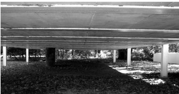
Forjado de la casa Farnsworth
