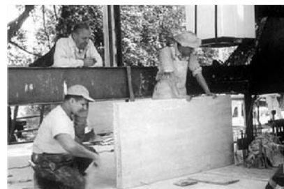
Operarios trabajando en la casa Farnsworth.
