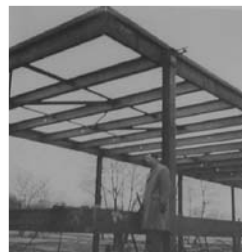
La casa Farnsworth en fase de estructura.
