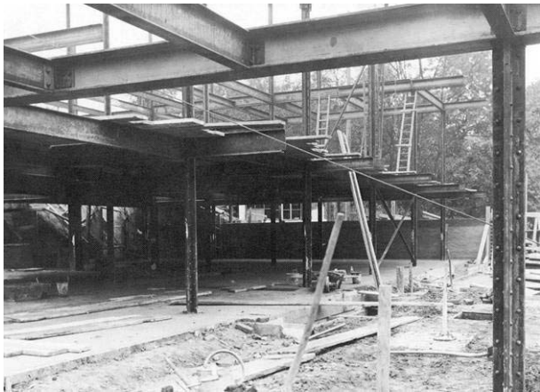
Estructura metálica durante su construcción (18 de octubre de 1929)
