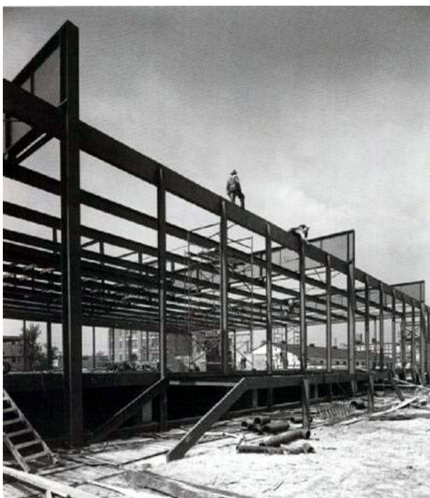
Construcción del Crown Hall, 1950-56
