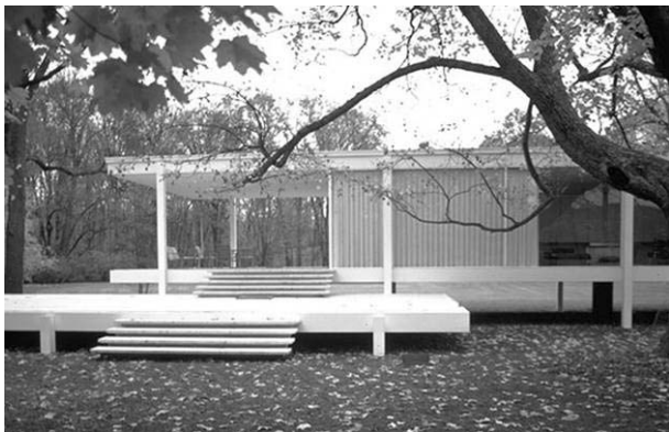
Escaleras de acceso. Casa Farnsworth
