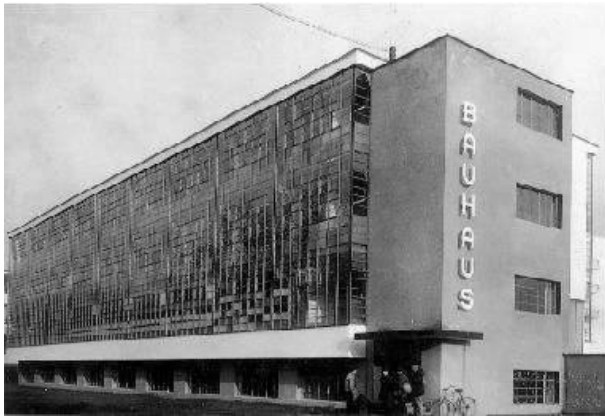
Edificio de la Bauhaus
