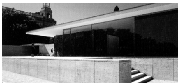
Pabellón de Barcelona. Detalle del podium
