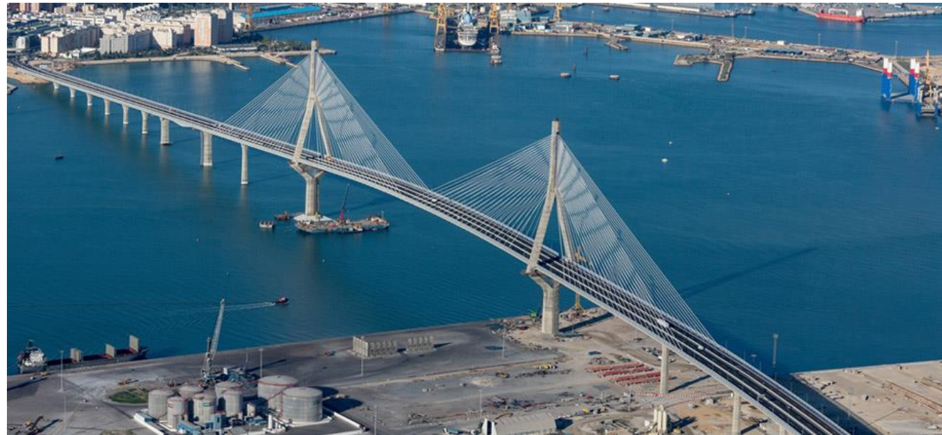
Puente La Constitución CA = 64,00 m sobre cero hidrográfico
