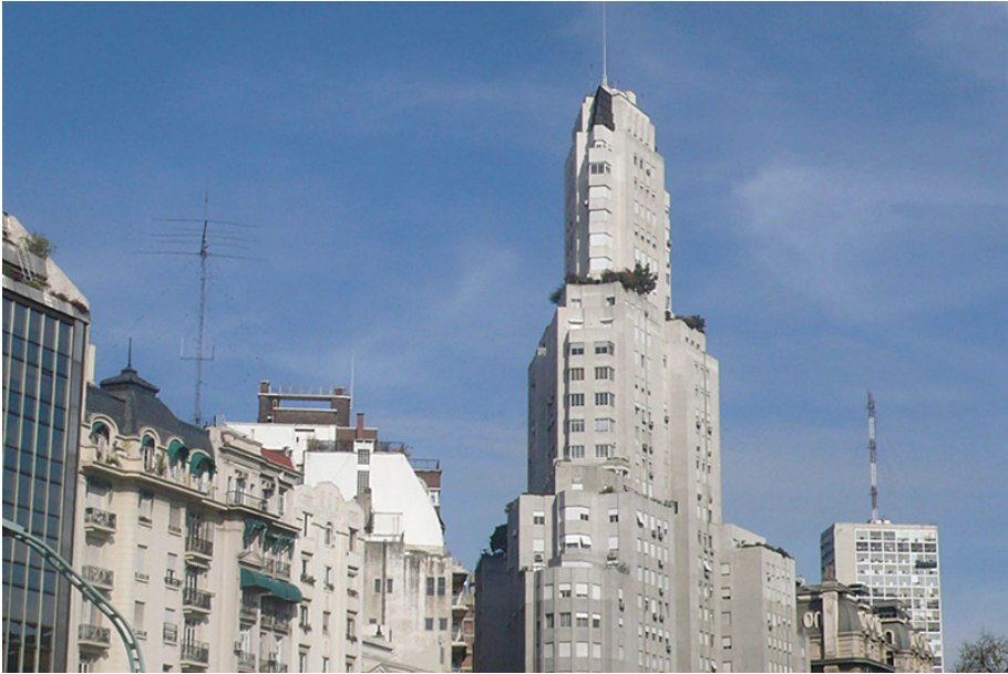
Fig. 3 – Buenos Aires, Edificio Kavanagh (1936): uno dei più celebri esempi di International Style in America Latina
