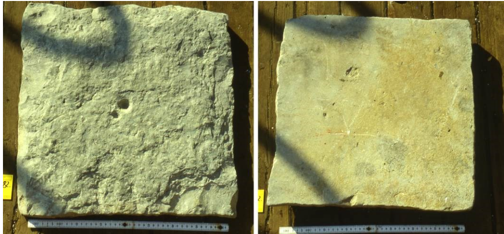
Abbildung 39: Hiddensee 12 . Beispiel des einfachen Formates der Kalksteinfliesen. Die grob zurechtgeschlagene Unterseite links und die geschliffene Oberseite rechts.
