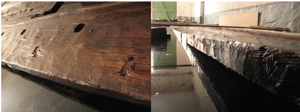
Abbildung 72: Poel 11. Die Planken des Schiffes zeigen deutliche Spuren der Bearbeitung mit der Axt. Die auf der Innenseite doppelt umgeschlagenen Eisennägel haben auch hier ihre charakteristischen Abdrücke hinterlassen. Wie bei Hiddensee 12 liegen auch hier die Holznagelverbindungen zu den Spanten unmittelbar über den Landungen.
