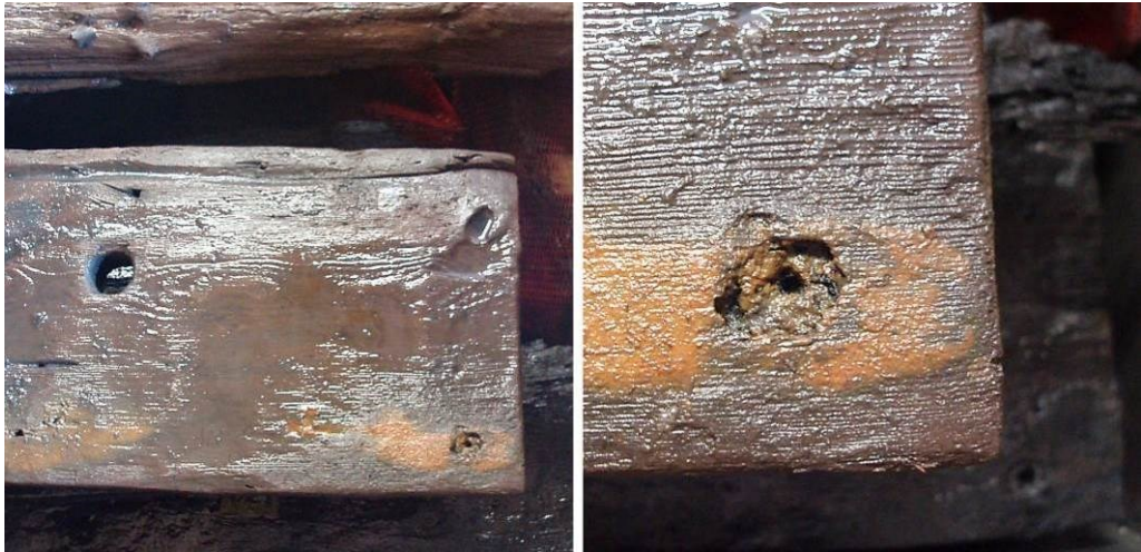
Abbildung 74: Poel 11. Abdruck eines Eisennagelkopfes in der oberen inneren Ecke einer Planke, direkt neben dem Plankenstoß. In diesem Bereich stehen die Eisennägel vermutlich in Verbindung mit einer temporären Verbindung während des Baus.
