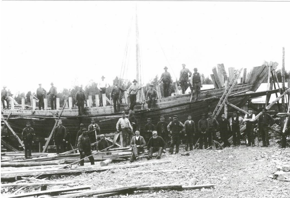
Abbildung 120: Diese historische Fotografie aus dem Jahr 1902 zeigt einen bis über die Kimm aufgezimmerten geklinkerten Schiffsrumpf in den bereits die Auflanger für die karweel beplankten Bordwände aufgerichtet sind. Diese Vorgehensweise hat große Ähnlichkeit mit der niederländischen bodenbasierten Karweelbaumethode.
