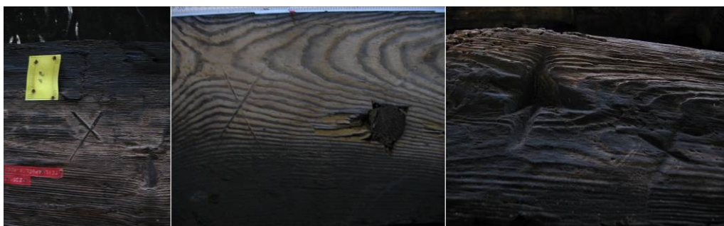
Abbildung 84: Poel 11 . Die Kreuzmarkierungen an den Oberseiten der Spanthölzer zeigen Positionen an, an denen keine Holznägel gesetzt werden durften um die darunter liegenden, auf Stoß gesetzten Plankenenden nicht zu beschädigen. Sie dienten auch dazu, falsch gesetzte Kerben von Bohrungen für Holznägel auszuschließen.
