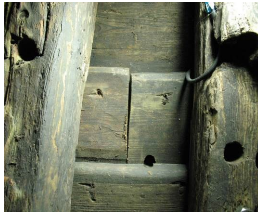
Abbildung 16: Hiddensee 12. Auf Stoß gesetzte Planken innerhalb der Plankengänge. Hier ohne das ursprünglich über der Verbindung befestigte Laschblatt.
