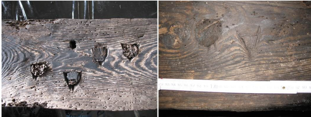
Abbildung 83: Poel 11 . Die dreieckigen Kerben zur Vorbereitung der Bohrungen für die Holznagellöcher sind deutlich an den Oberflächen der Bodenwrangen zu erkennen (links). Das Setzen einer Kerbe an einer falschen Position wurde abgebrochen und die Position korrigiert (rechts).
