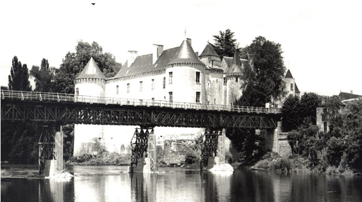
Le pont provisoire
