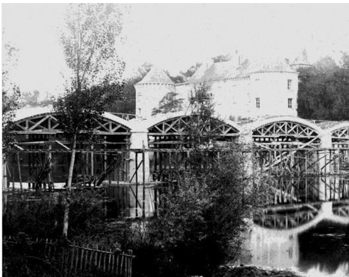
Le vieux pont en construction
