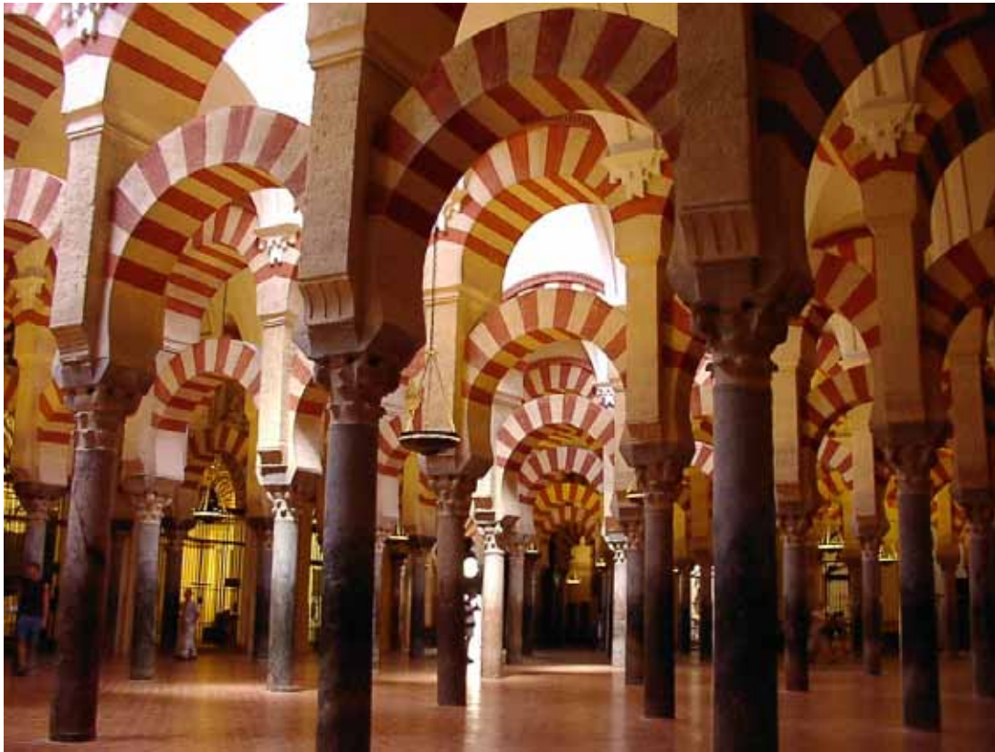
Fig. 5: Bandas rojas de los arcos la Mezquita de Córdoba pintadas con Colcátar (óxido de hierro). Foto José Ubay Suárez Navarro.
