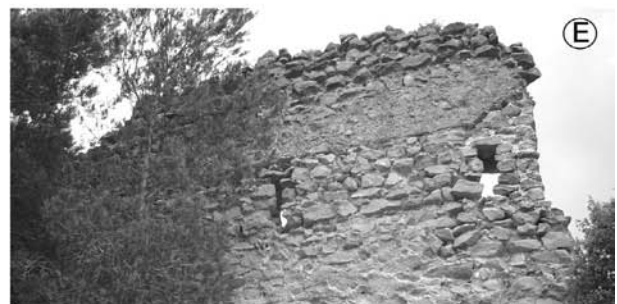
Figura 6: La técnica del tapial. A: Partes de un tapial según las improntas encontradas en las torres valencianas (Fuente: Rodríguez Navarro, 2008; 233, fig. 8,137). B: Fachada sureste de la torre señalando las líneas de las tapias. C y D: Travesaños que se conservan en el cuerpo del muro. E: Muro del recinto donde se leen muy nitidamente las líneas de tapias.
