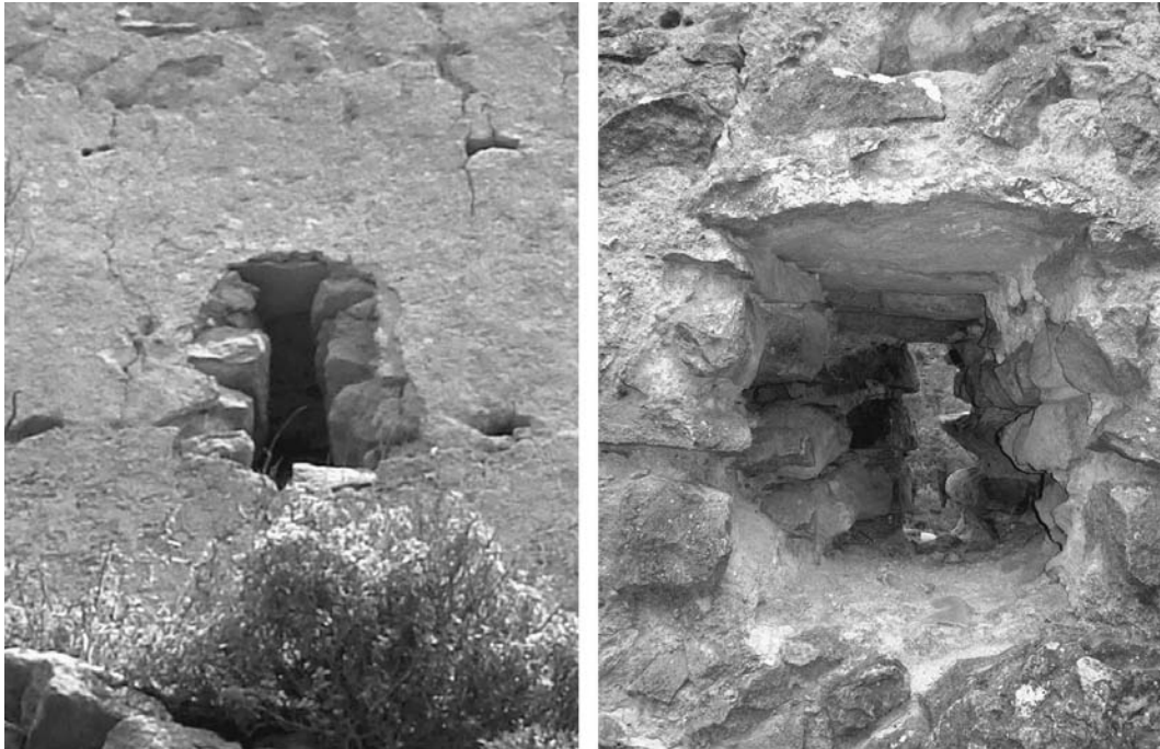
Figura 10: Saeteras. De izquierda a derecha. Fotografía de la cara exterior de una de las saeteras de la torre, imagen de la misma saetera desde la cara interior donde puede observarse el abocinamiento característico para permitir posicionarse al tirador y la resolución del dintel con la colocación de una pieza de piedra mayor y ligeramente escuadrada.
