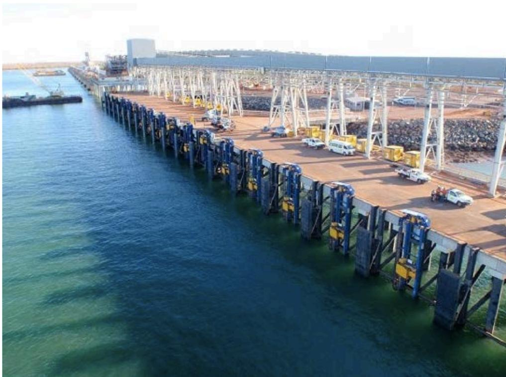
**Ilustración 16:** *Unidades MoorMaster preparadas para amarre del usuario en el Puerto de Hedland's Utah. (Fuente: [www.cavotec.es](http://www.cavotec.es))*
