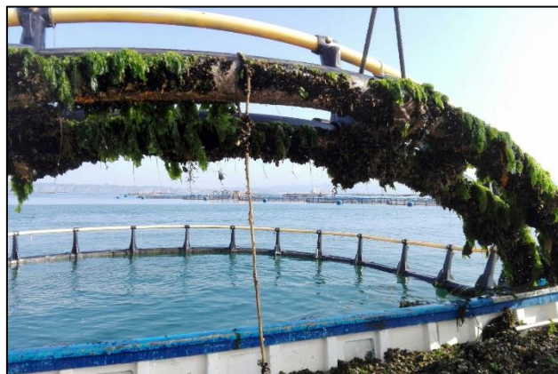
Fig. 15. Fouling en los anillos.
