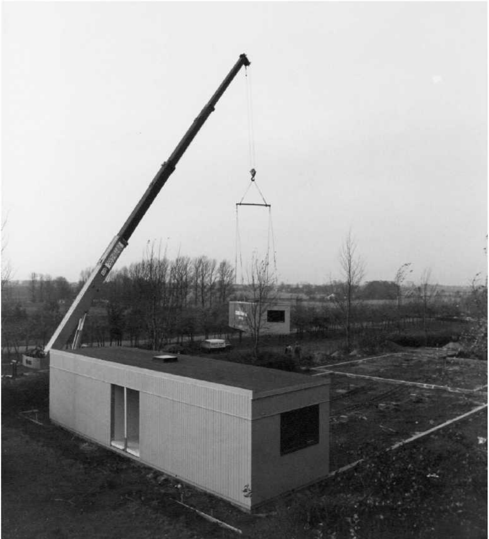
Midlertidig udbygning af RUC, 1987.
