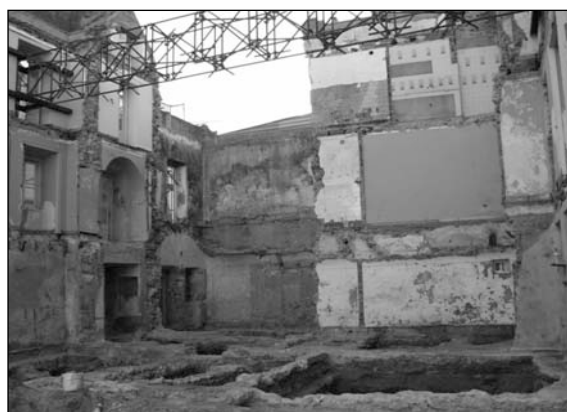
Figura 4 – Lado Este do edifício, vista final da intervenção.
