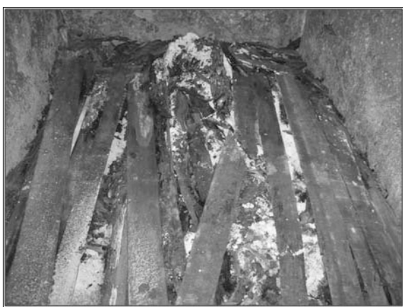
Figura 13 – Cripta 2 da capela do Espírito Santo, início da intervenção.
