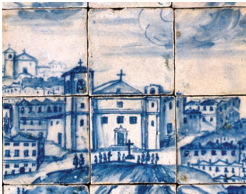
Fig. 3 – Pormenor da Igreja de Santa Catarina com a torre em construção.
